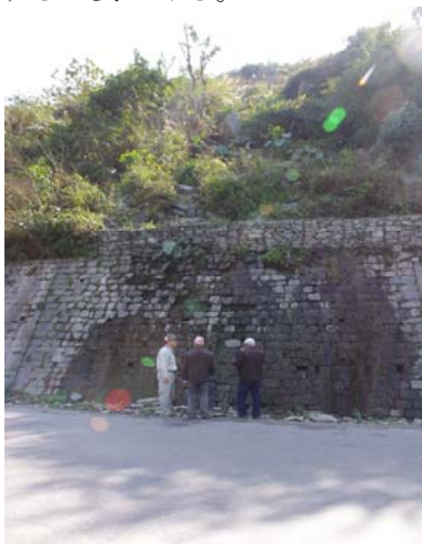
老朽化した擁壁
