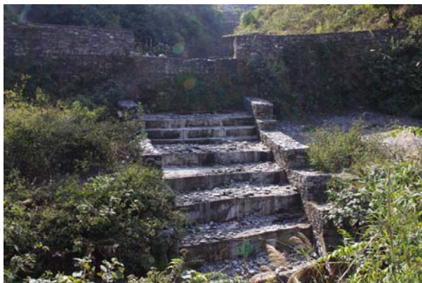
堰堤工の状況と道路の状況
