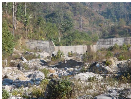
DWIDP によるコンクリート砂防えん堤
