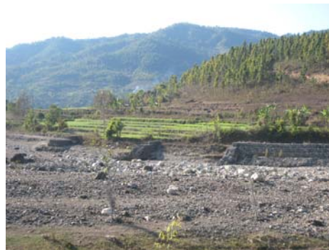
河床低下により根が浮き根継ぎ修復された水制工（左）と被災したままの水制工（右）
