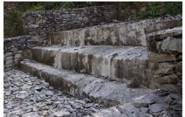
前提部の磨耗状況
