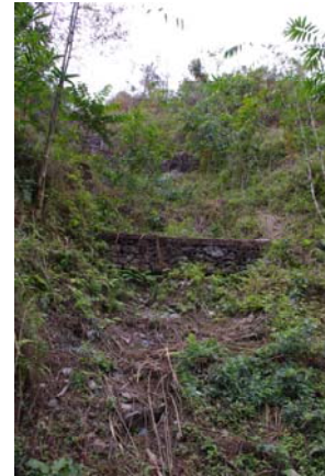
調査地点の状況(中央付近にふとん籠の谷留工、袖部には竹が植栽されている。)
