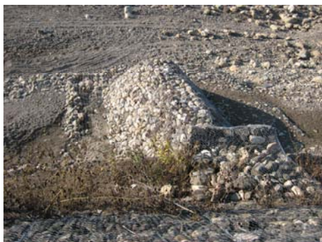
河床低下により根が浮き根継ぎ修復された水制工（左）と被災したままの水制工（右）
