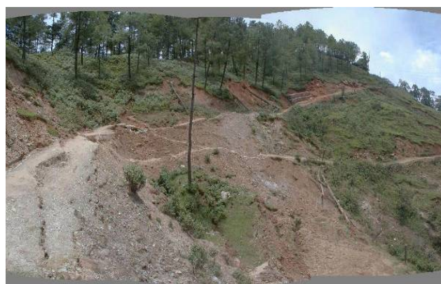
植林前の源頭部付近の状況（2001 年頃）
