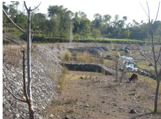
現在の護岸工と水制工
