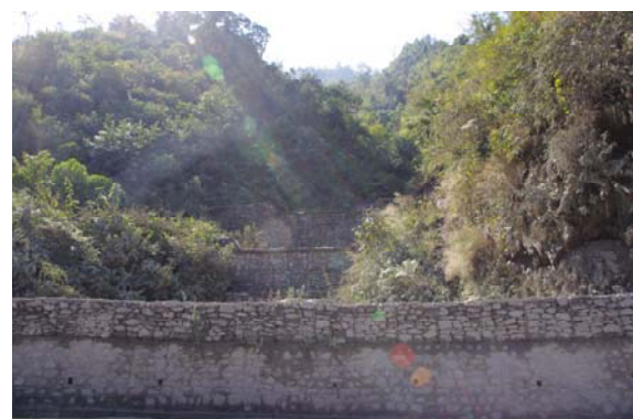
道路沿いの擁壁から砂防えん堤を望む
