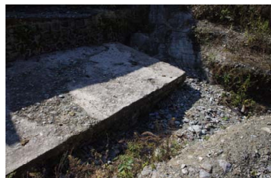
袖部の貫入状況
