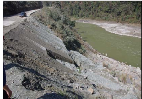
暗渠部の閉塞状況
