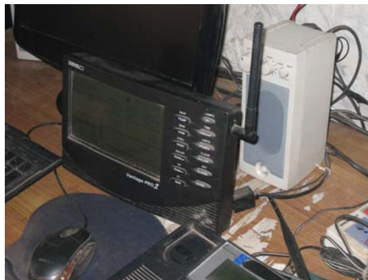
雨量計の情報による警報装置 (JICA 提供) 警報装置は村長の机の上に置かれていた
