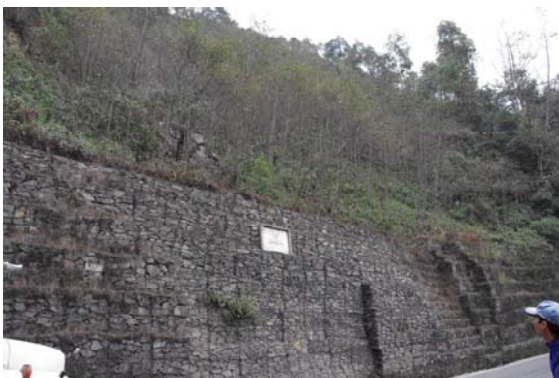
ふとん籠による擁壁工の状況
