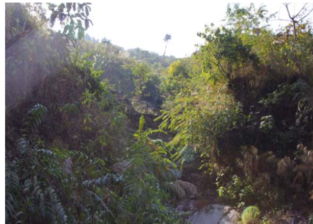
擁壁上部の状況
