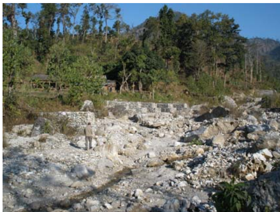
下流域に設置されたふとん籠による水制工
