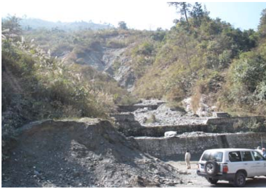
堰堤と溪流の荒廃状況
