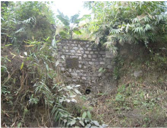
調査地点の状況(中央付近にふとん籠の谷留工、袖部には竹が植栽されている。)
