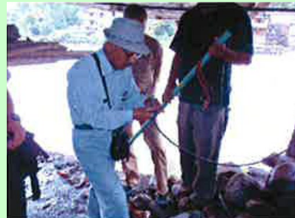
既設水位計の点検
