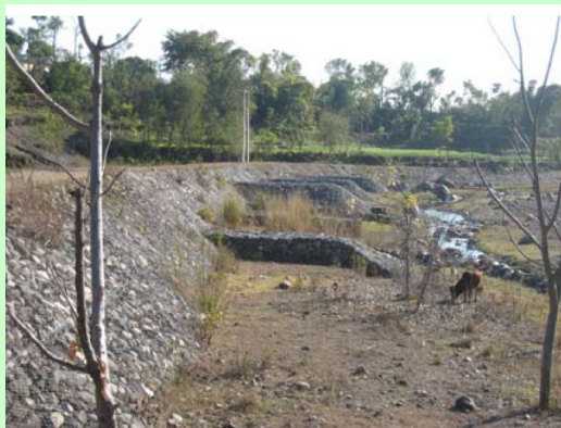
ギルバリモデルサイト 水制工が効果を発揮している
