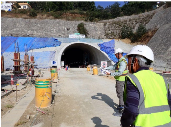
写真 Nd-1 カトマンズ側入口
