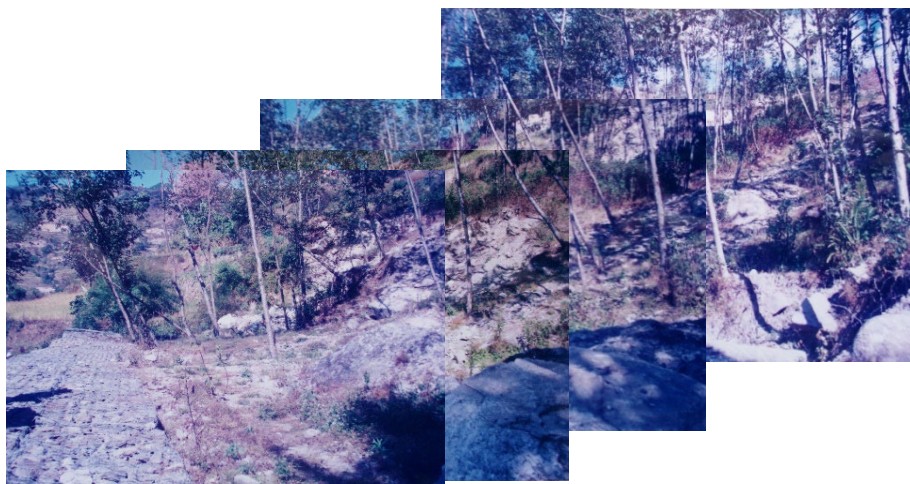
写真 LS6 ブロック I 末端部の押さえ盛土と布団かご擁壁 (1997 年 11 月)
