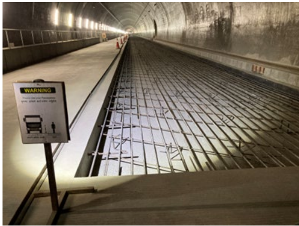
写真-Nd5 鉄筋コンクリート舗装工事 中の路床
