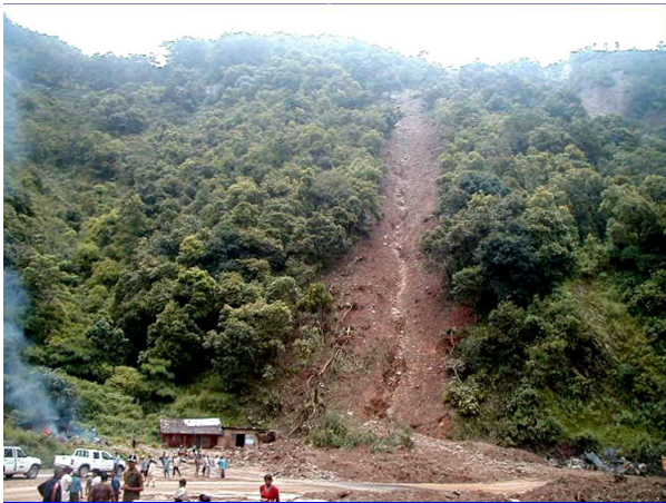
写真 KN-3 Ch15+100 地点 2002 年 7 月の崩壊流下土砂により被災 2002 年 7 月（大本撮影）（左）、 その後、道路局では、DMSP からの技術アドバイスの一部である布団かご擁壁のみで対処（右） 2003 年 2 月（大本撮影）
