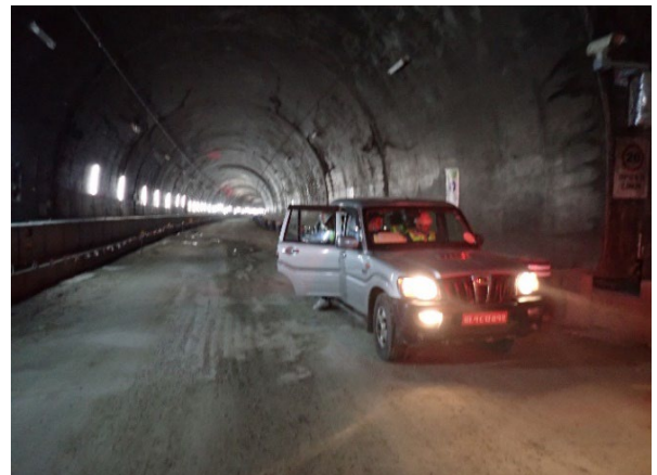
写真 Nd-2 トンネル内
