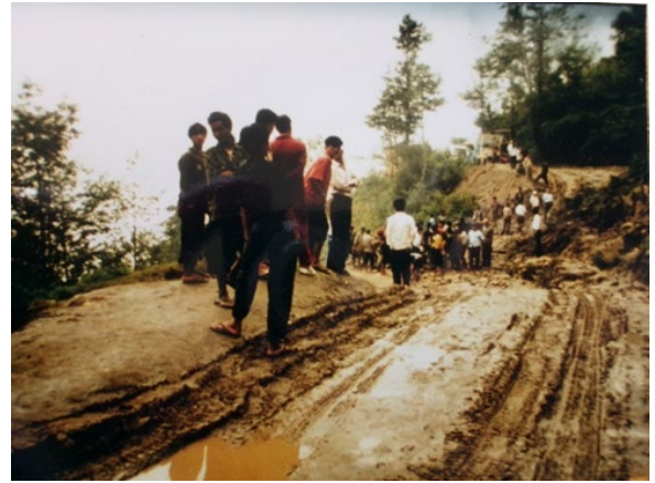
写真 LS4 1996.8 月豪雨による顕著な地すべり 災害状況 (車が通れず徒歩で通行)
