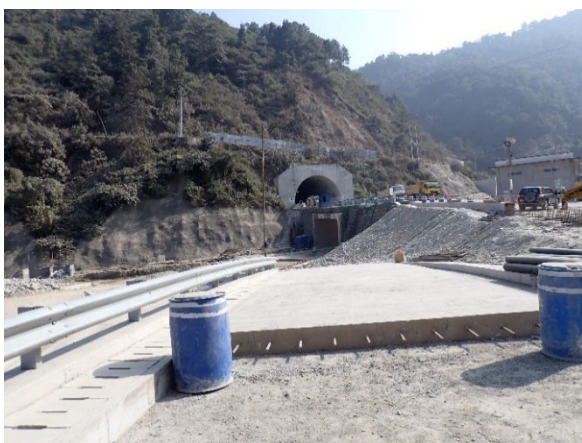
写真 Nd-3 ノービセ（インド）側入口 ートンネルの上は現国道
