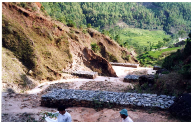
写真 P7 施工当時のメインガリーでの低蛇 かご砂防堰堤群（1996 年）（檜垣撮影）
