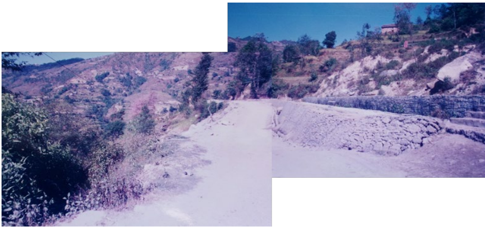
写真 LS5 対策工事後の 1997 年 11 月(道路面が現況なりに復旧され、用水路が元の位置に改修された)
