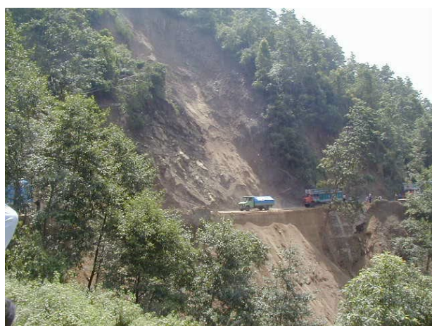
写真 KN-1 Ch13+000 地点 崩壊発生直後の状況 2001 年 9 月（亀江撮影）
