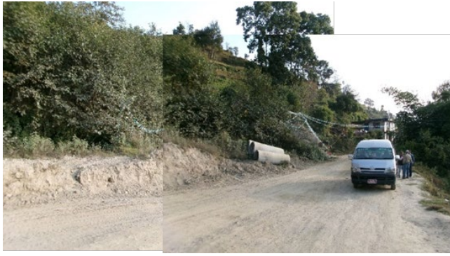
写真 LS3 地すべり通過区間を、写真を反対側から 写真 LS1 を望む (2024.11.25)
