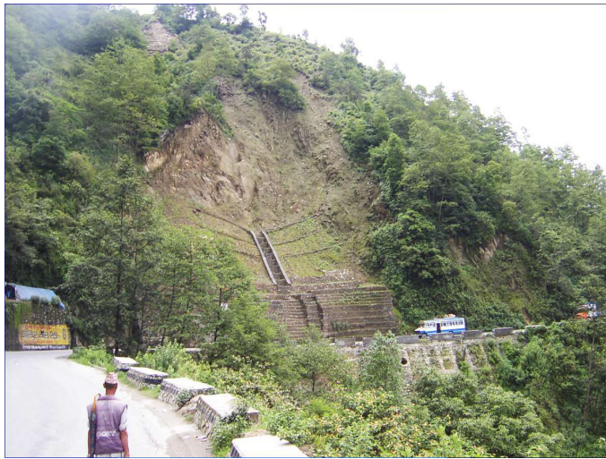
写真 KN-2 Ch13+000 地点 草の根無償による道路斜面崩壊対策（2002 年完成）施工後の状況 2004 年（大本撮影）
