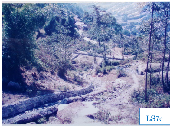
写真 LS7 ブロック I 上部に完成 していた表面排水工（1997 年 11 月 北原撮影）
