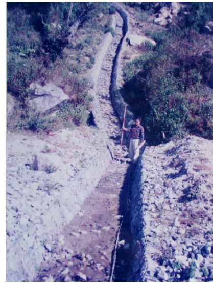
写真 LS7 ブロック I 上部に完成 していた表面排水工（1997 年 11 月 北原撮影）
