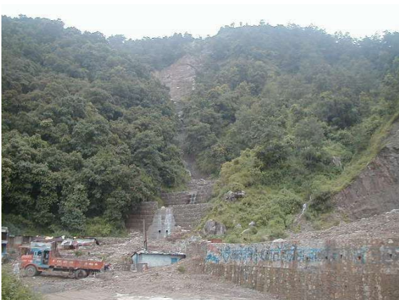
写真 KN-4 Ch15+200 地点 DMSP により完成したチェックダム。2002 年 7 月豪雨での施設被災無 し 2002 年 7 月（大本撮影）。
