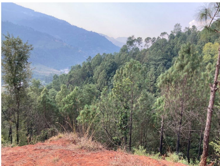
写真 p10 ガリー侵食対策を実施した斜面の 2024 年 11 月の状況
