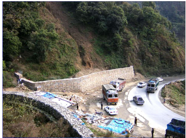
写真 KN-3 Ch15+100 地点 2002 年 7 月の崩壊流下土砂により被災 2002 年 7 月（大本撮影）（左）、 その後、道路局では、DMSP からの技術アドバイスの一部である布団かご擁壁のみで対処（右） 2003 年 2 月（大本撮影）
