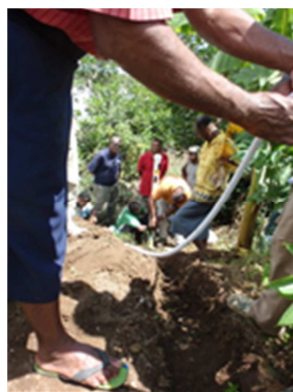
保護管にケーブルを通して 埋設 (Fiji 2011)
