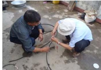
銅線の劣化によるケーブルの断線の補修作業状況
