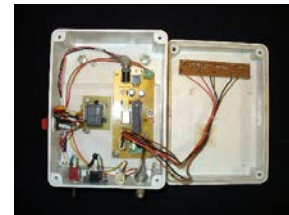
ICIMOD Wireless 受信側(内部)
