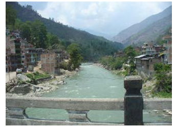
Barhabise の昔の水位観測所
