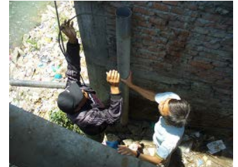
取外したケーシング
