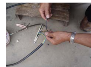
モニター側結線補修
