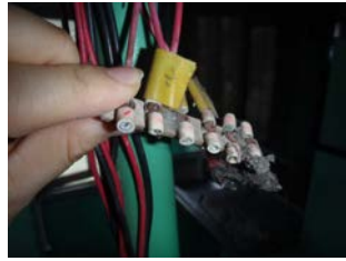
ケーブルとの接続（ケーブル側が完全に断線）
