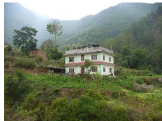
雨量計を設置していた家
