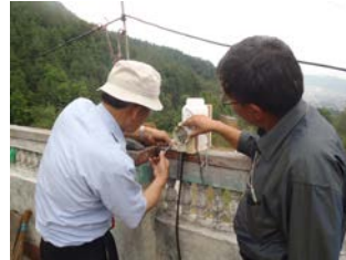
雨量計側結線補修
