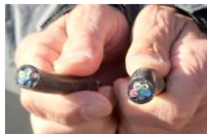
芯が腐食したケーブル
