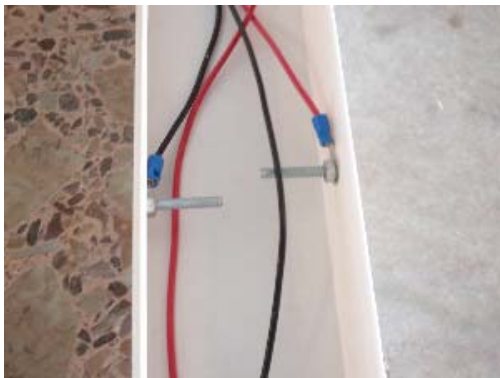
箱型内部のセンサーと配線
