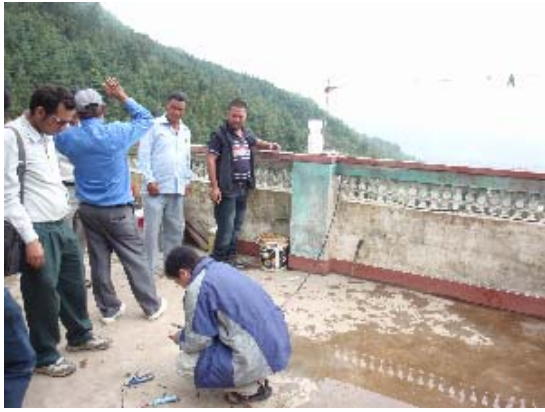
ケーブル側接続端子作り
