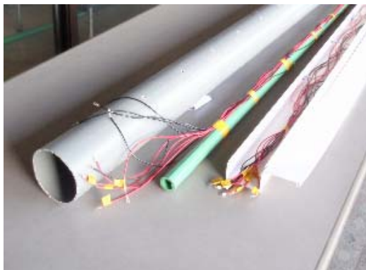
水位計頭部配線状況
