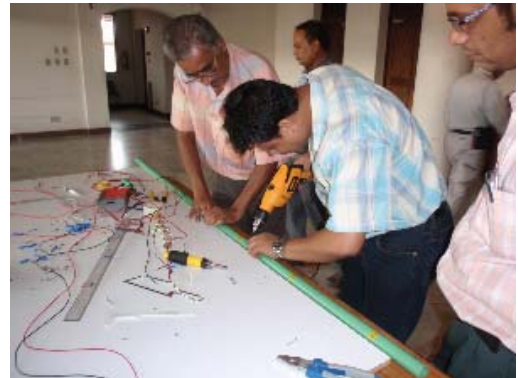
筒型センサー部支柱のせん孔
