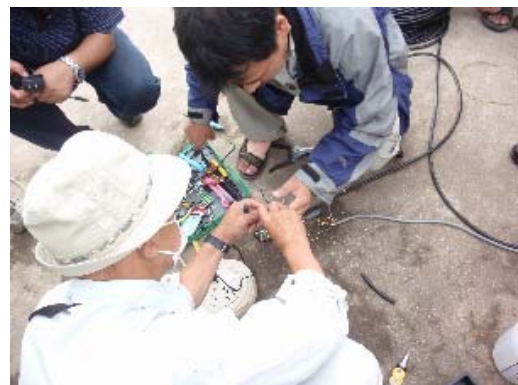
ケーブル側接続端子作り
