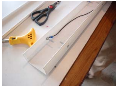
箱型水位計内部配線
