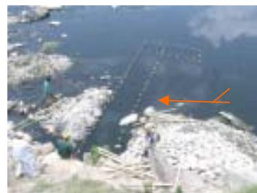
竹柵による低水位用水制工（施工中）
