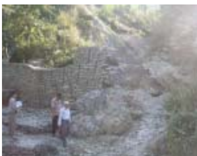
左岸側袖部を破壊されたガビオンダム (左：津守所員、右：ジョシ所長代理)
