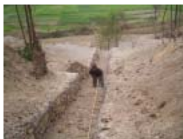
確認（検査）の状況
