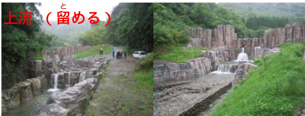
上流の砂防堰堤の状況 (擬岩ブロックによる自然景観との融合、魚道の整備)
