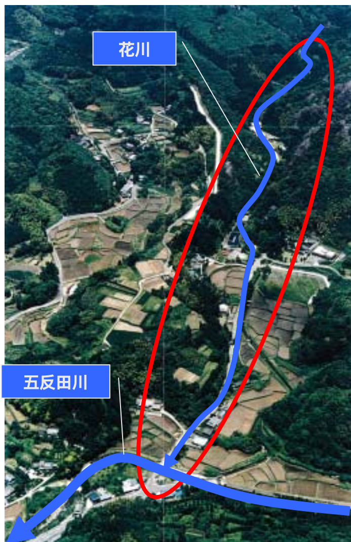
写真 2 花川の全景( 工事着手前 )
