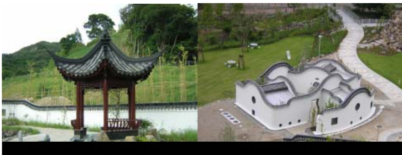
下流の遊砂地として整備された高水敷の状況（防災機能の維持増進） 利活用整備施設の状況（中国風の景観づくりによる交流空間の創造）
