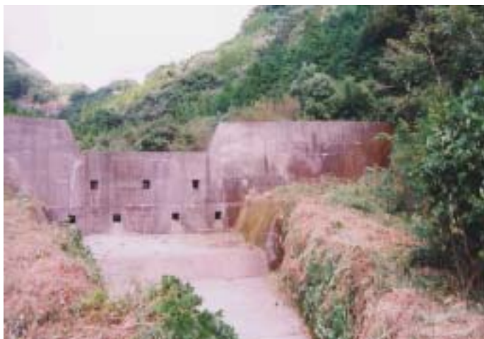
写真 8 整備された砂防堰堤
