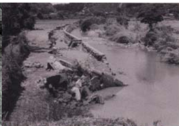
写真 7 河川氾濫の状況
