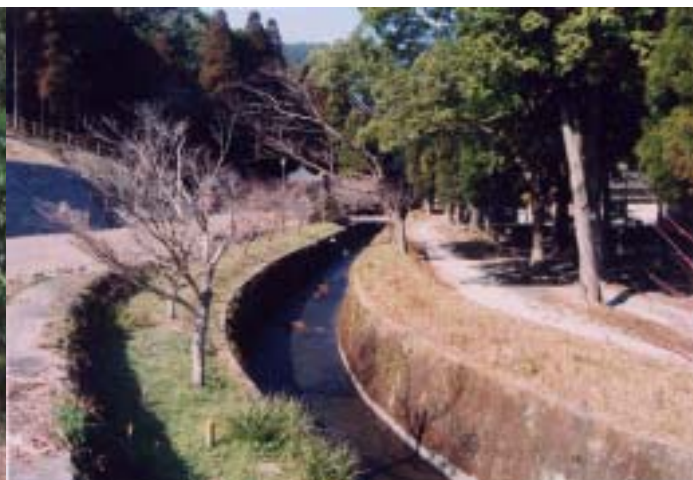
写真 9 整備された流路工
