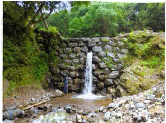
峯坂沢第4号堰堤 (平成28年6月1日撮影)
