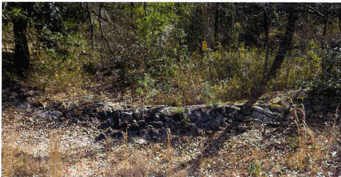
明治33年施工の石積堰堤（平成28年2月24日撮影）
