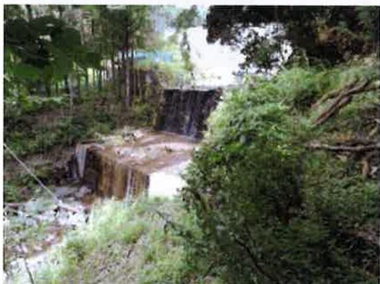
峯坂堰堤 (平成 28 年 8 月 17 日撮影) [静岡県砂防課提供]
