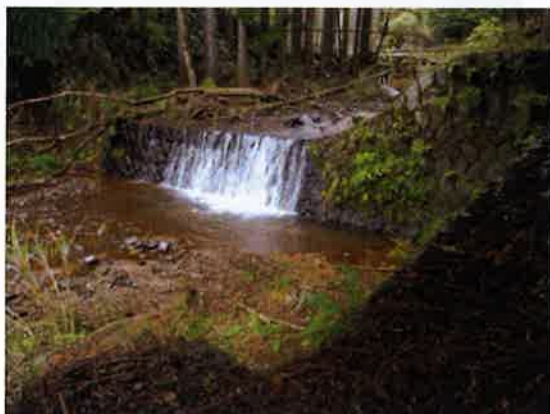
堰堤正面 (平成26年11月11日撮影)
