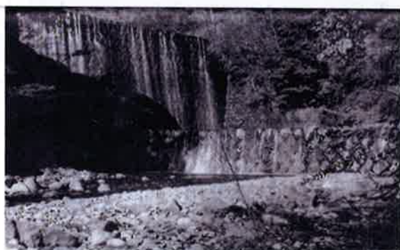
下流正面より本副両堰堤を望む
