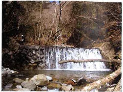
白石沢第2号堰堤 (平成28年3月2日撮影)
