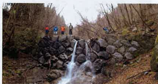
堰堤正面 (平成27年12月10日撮影)
