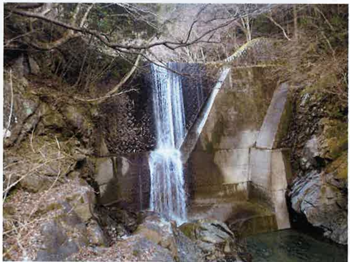
内務省笹小屋堰堤 (平成 28 年 3 月 2 日撮影)
