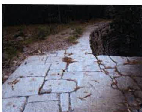
アーチ状の石積堰堤
