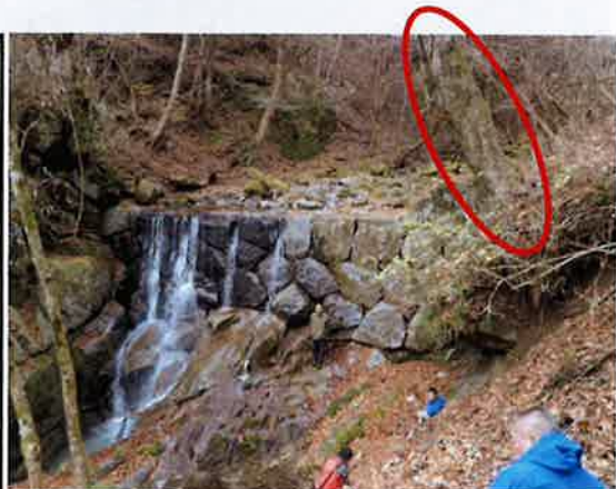
堰堤正面（平成27年12月10日撮影）
