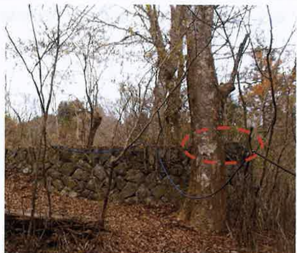
休泊所基礎の石積 (平成 27 年 12 月 10 日撮影)
