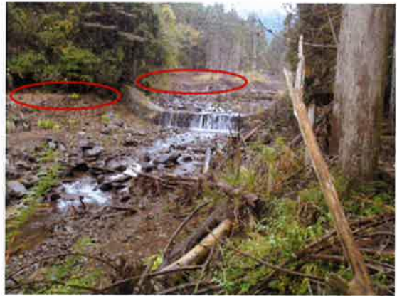
湯船沢上流堰堤 全景 (平成 26 年 11 月 11 日撮影)
