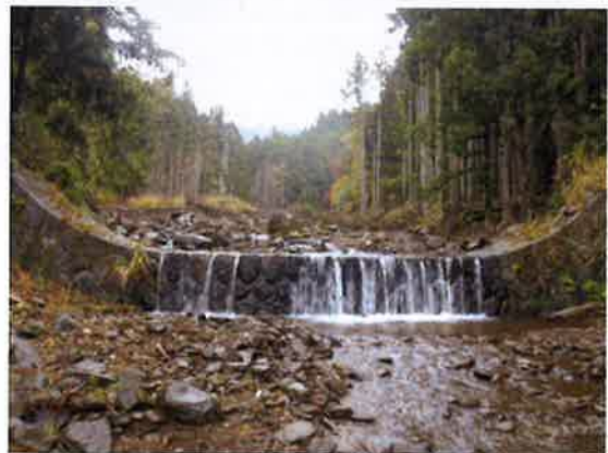
湯船沢上流堰堤 近景 (平成 26 年 11 月 11 日撮影)
