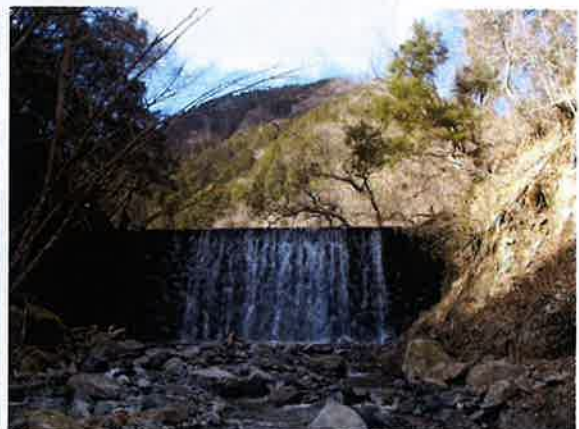
法行沢第 1 号堰堤 （平成 28 年 3 月 2 日撮影）
