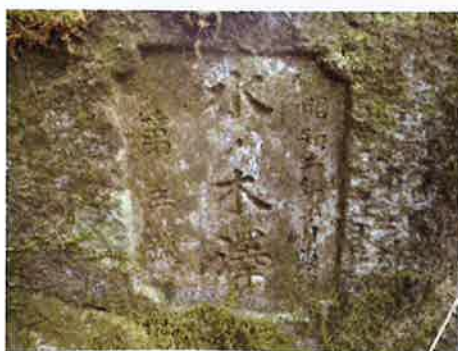
堤銘板文字 昭和二年十月竣工水ノ木沢 第三號 堤銘板 （平成27年12月10日撮影）
