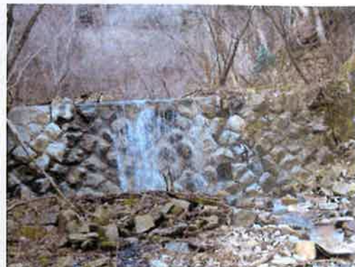
堰堤正面 (平成28年3月2日撮影)
