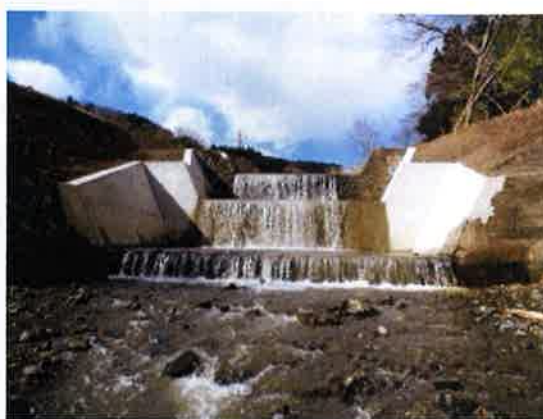
山口堰堤災害復旧後状況 (竣工時撮影) [静岡県砂防課提供]
