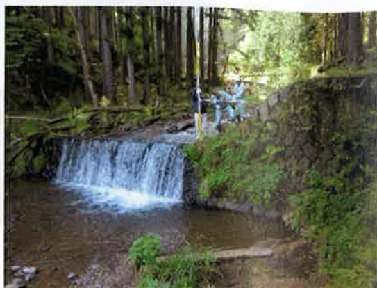
堰堤正面 (平成28年5月20日撮影)
