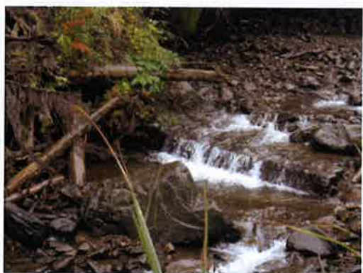
副堰堤 近接 天端のみ確認できる (平成26年11月11日撮影)
