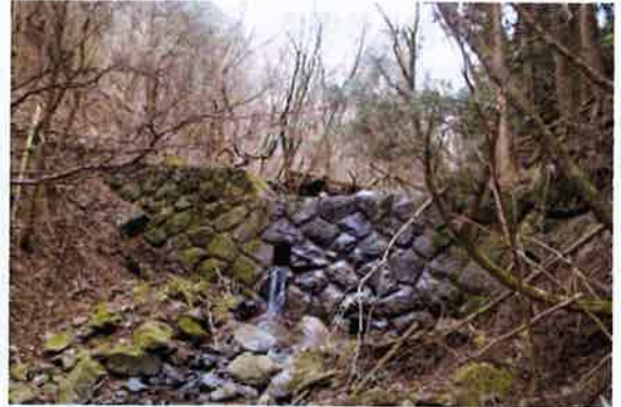
堰堤正面（平成27年12月10日撮影）
