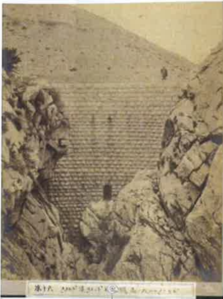
Wildbach Skurda" in Montenegro/ Thalsperre Nr. 1 / 16,10 m hoch/ in Portland-Cementmauerung 「スクルダ」溪「セメント」石堰堤 高十六、一〇「メートル」
