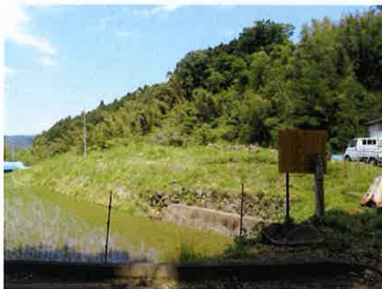
隆起地を城川左岸側から望む (平成 28 年 6 月 2 日撮影)
