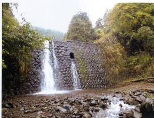
湯船沢堰堤 近景 （平成26年11月11日撮影）
