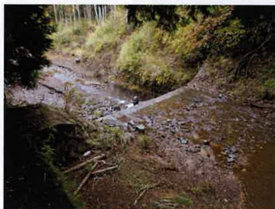
堰堤水通し部 (平成26年11月11日撮影)
