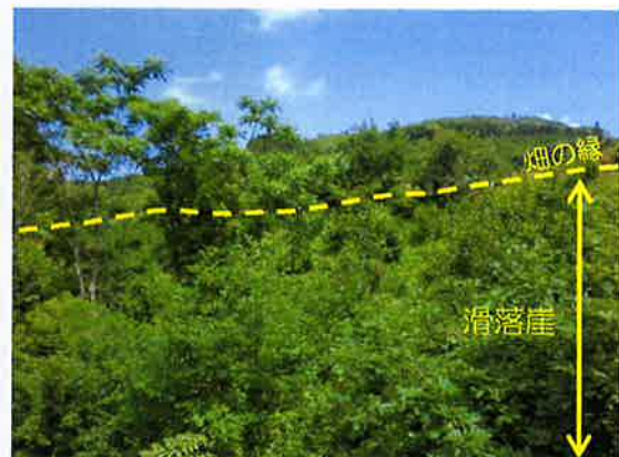
陥没地中腹から滑落崖を望む （平成 28 年 6 月 2 日撮影）
