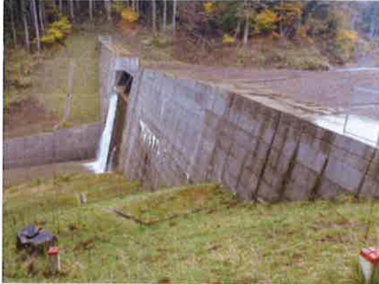
湯船沢最下流のコンクリート堰堤 (平成 26 年 11 月 11 日撮影)
