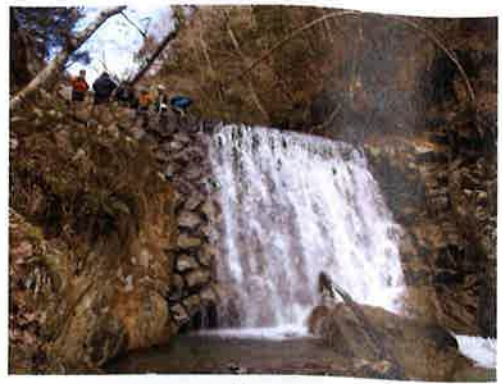
白石沢第1号堰堤 (平成28年3月2日撮影)
