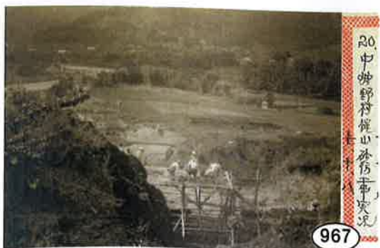
中狩野村梶山 砂防工事実況 (昭和 7 年 10 月 8 日撮影) [諸戸北郎博士アルバム]
