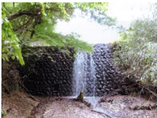
小野畑堰堤 (平成 28 年 8 月 17 日撮影) [静岡県砂防課提供]
