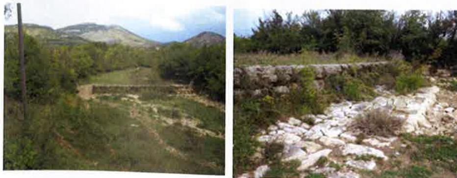
道路橋上流側における石積堰堤の状況
