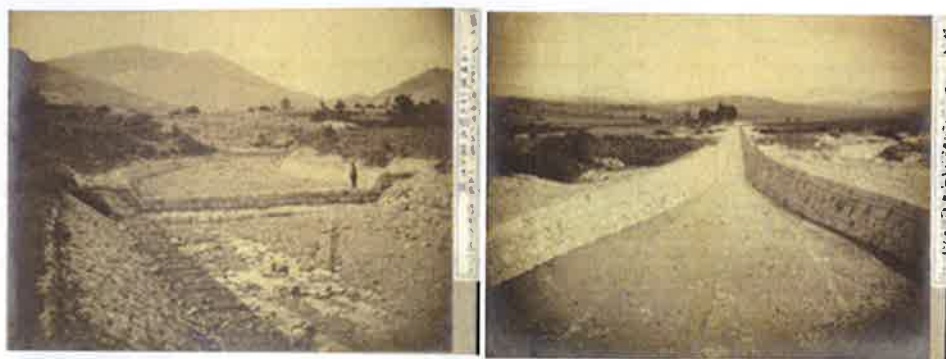
諸戸博士の写真（左：石積堰堤、右：流路工）
