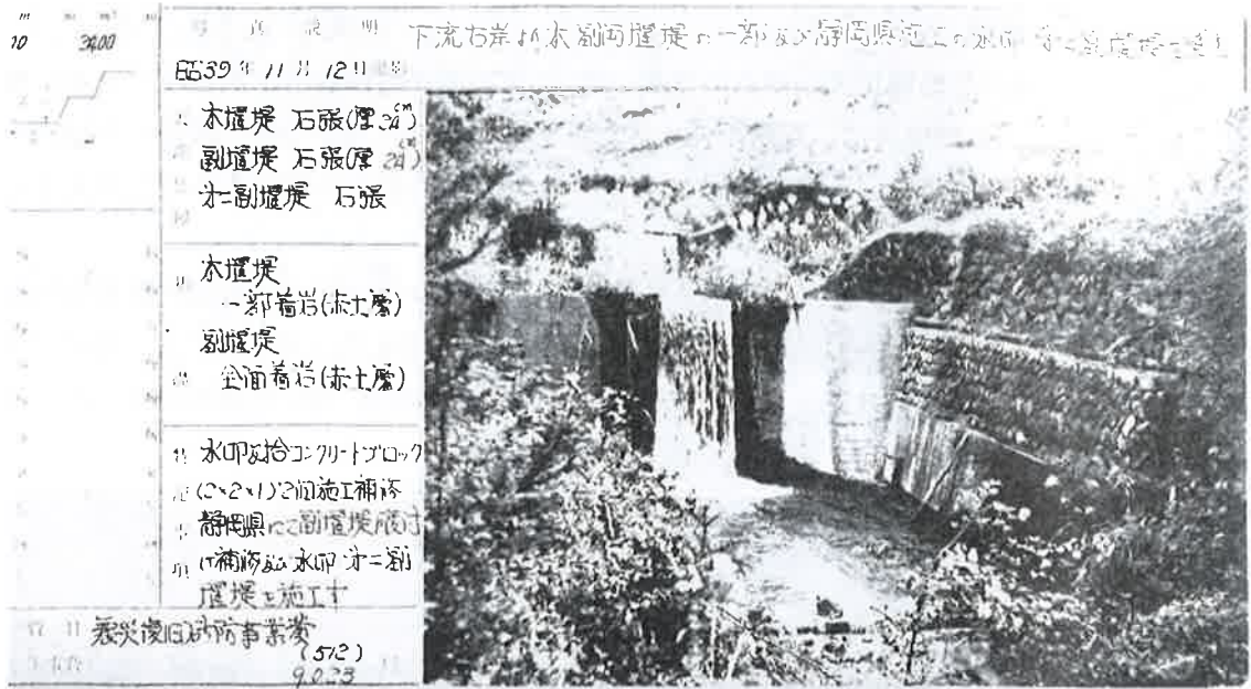
昭和39年11月12日撮影の湯船沢上流堰堤
