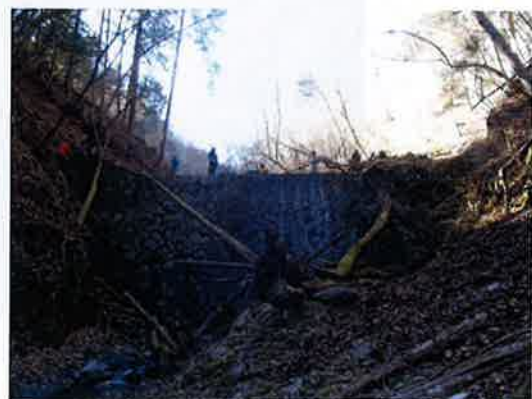
法行沢第 2 号堰堤 （平成 28 年 3 月 2 日撮影）
