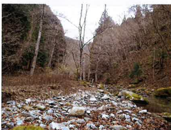
堰堤上流の状況（平成27年12月10日撮影）
