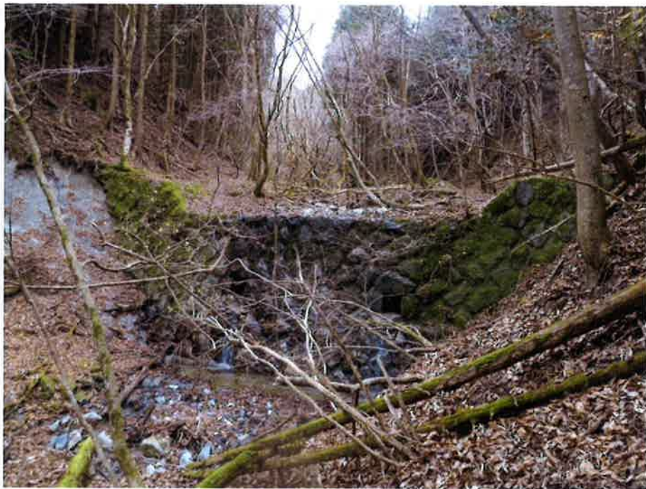
金山沢第2号 練石積堰堤 (平成27年12月10日撮影)
