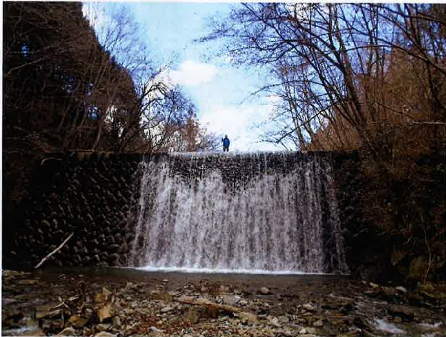
帝室林野局大又沢堰堤（平成 28 年 3 月 2 日撮影）
