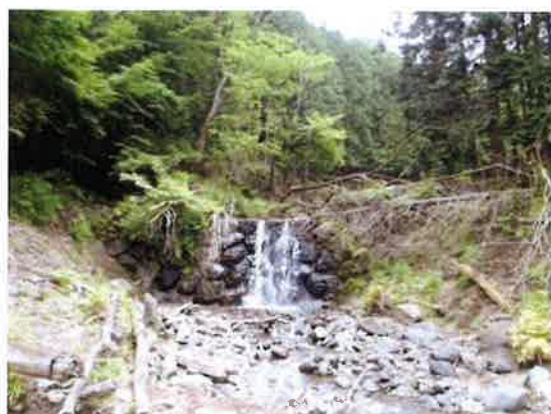
峯坂沢第3号堰堤 (平成28年6月1日撮影)
