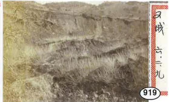
城の陥没地（昭和 6 年 2 月 9 日撮影） [諸戸北郎博士アルバム]
