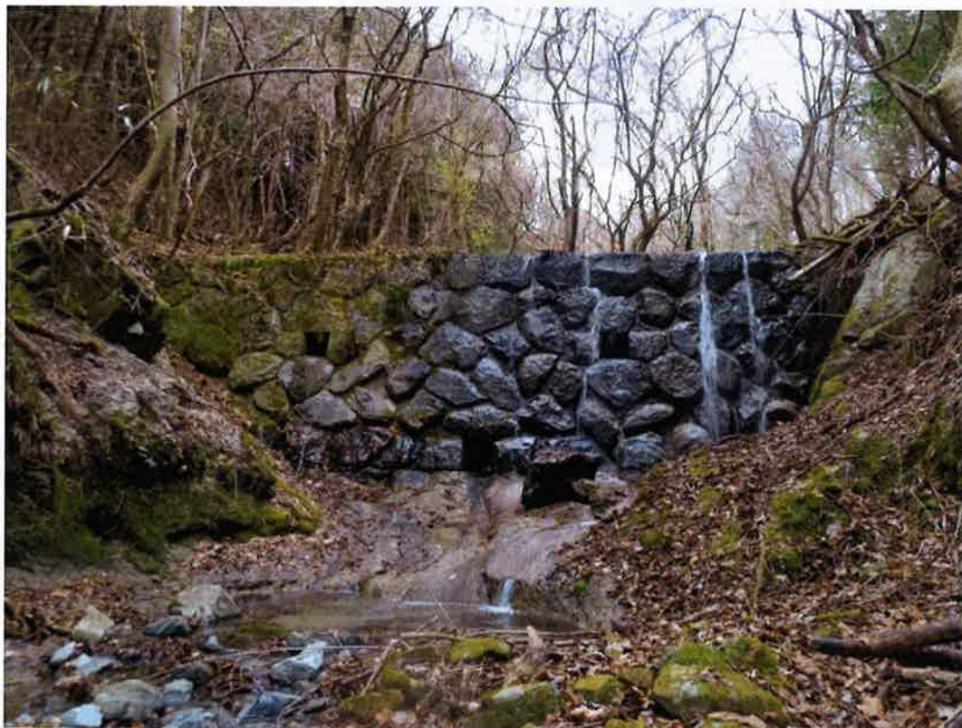
金山沢第3号 練石積堰堤（平成27年12月10日撮影）
