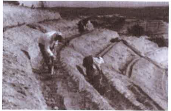
施工状況 (昭和中期)
