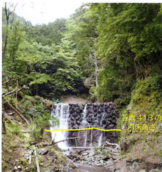
峯坂沢第2号堰堤 (平成28年6月1日撮影)
