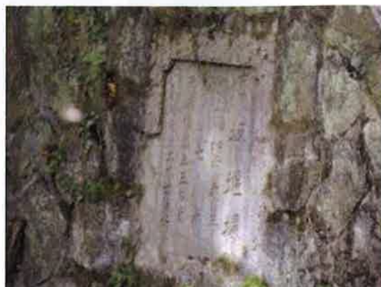
峯坂堰堤 堤銘板 (平成 28 年 8 月 17 日撮影) [静岡県砂防課提供]
