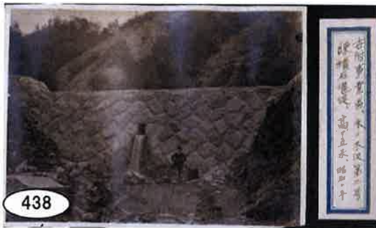
438 水ノ木沢第2号 練石積堰堤(昭和2年撮影) [諸戸北郎博士アルバム]
