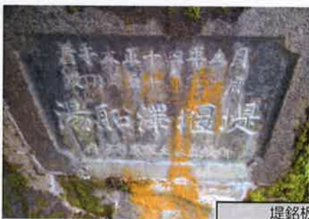
堤銘板文字 着手大正十四年五月 竣功大正十五年二月 湯船沢堰堤 内務省東京土木出張所
