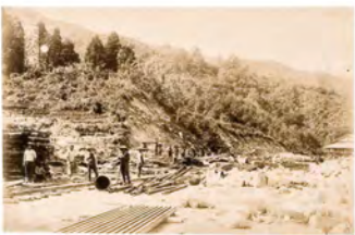
敦賀郡東蒲村河曾之合庭堂被災
