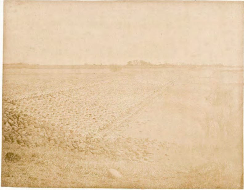
岐阜縣津市郡木曾町 大樽川旧堤(北西) 南東を望む
