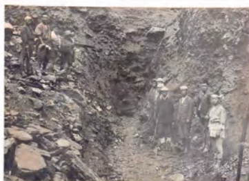
第三隧道の入口の破壊
