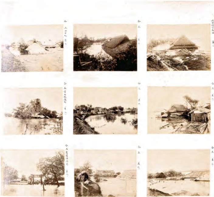
大坂府 大坂市 五條町 杉津人家 被害状況 第二
