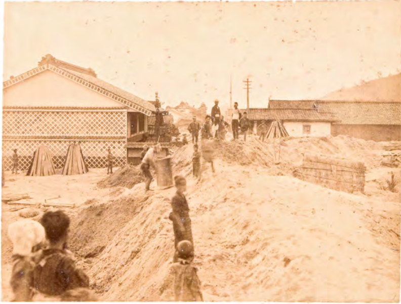
三吹組人家押入土砂道路掘出状
