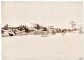
大垣市西區津島町南端より西へ望む。最悪水害全盛時。
