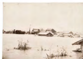
大垣市南區津島町南端より東へ望む。最悪水害全盛時。
