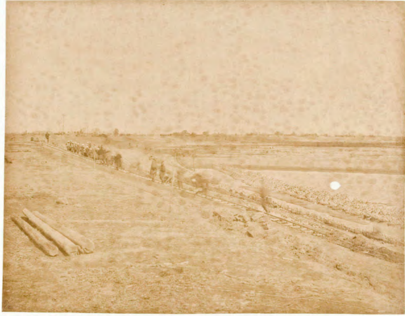
岐阜縣成戸木曾川之部 南西より 北東へ望
