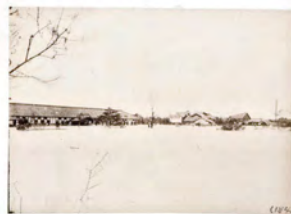
大垣市西區津島町南端より東へ望む。最悪水害全盛時。
