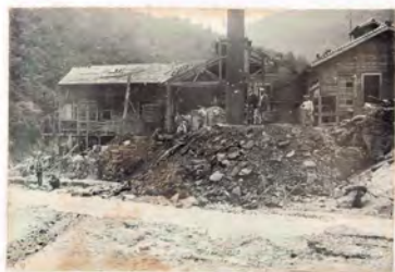
端島車道入口破壊
