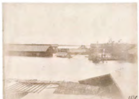
大垣市東區津島町南端より北へ望む。最悪水害全盛時。
