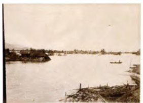
龍淵村河破潰所・望一（龍淵村大字）
