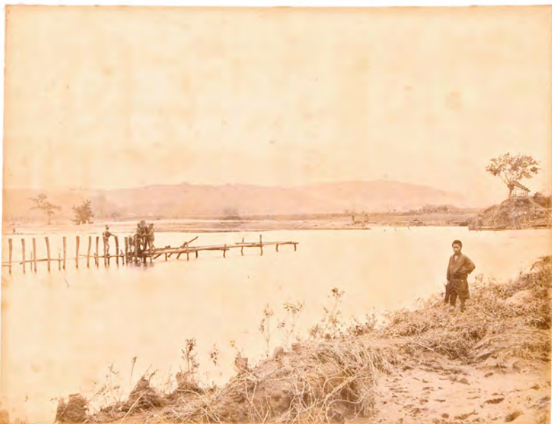
東八代郡上曾根村鵜飼川堤防欠落 田畑荒廃状
