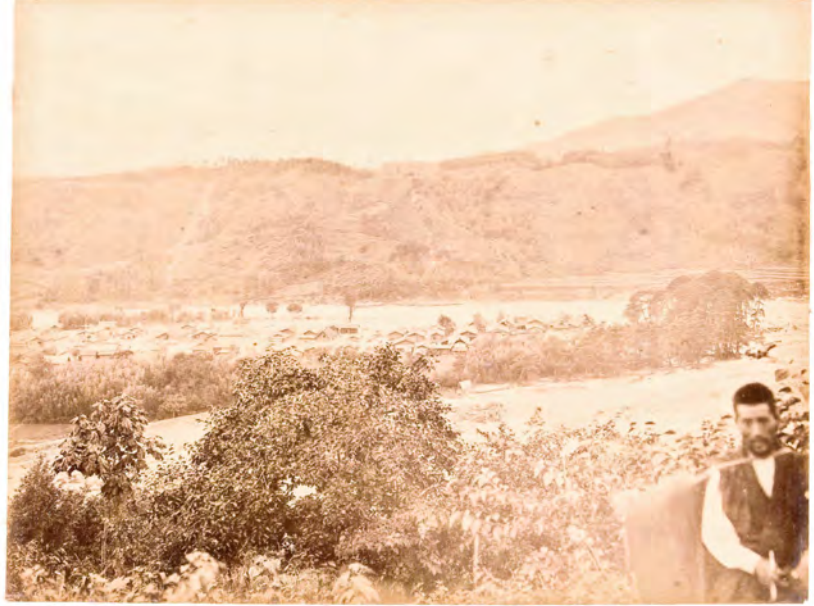
三吹全村流失ノ慘状
