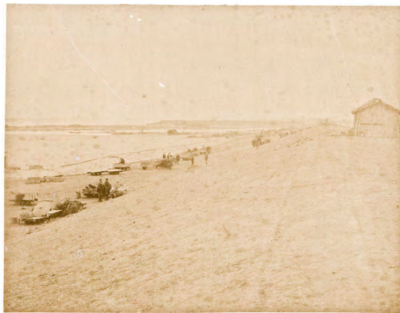
愛知縣 田部切西面 海東郡 北より 南西を望
