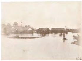
大垣市東區津島町南端より北へ望む。最悪水害全盛時。
