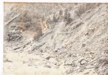
端島車道破壊
