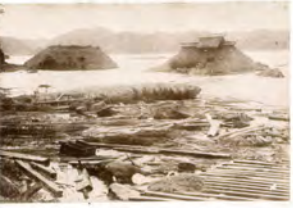
本吉郡柳井子同村被災現場 震災今も亦亦有之實況
