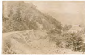
敦賀郡東浦村東浦川沿河被灾状况
