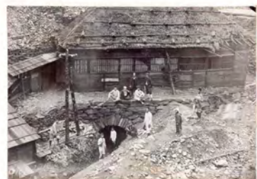
代々坑進口崩壊
