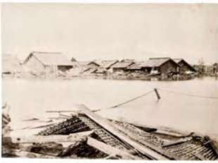
大垣市東區津島町南端より西へ望む。最悪水害全盛時。
