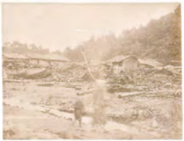
宮古銀嶺崎の津波被災實況
