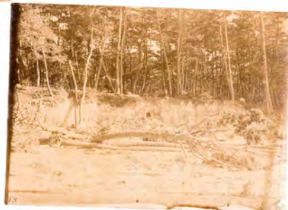
山梨県北巨摩郡清原村河原 堤二箇
