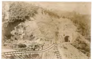
敦賀郡東浦村東浦川沿河被灾状况
