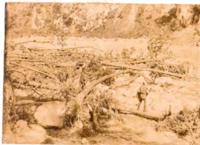
山梨県北巨摩郡清原村河原 堤二箇
