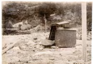
本吉郡清水村被害之實況
