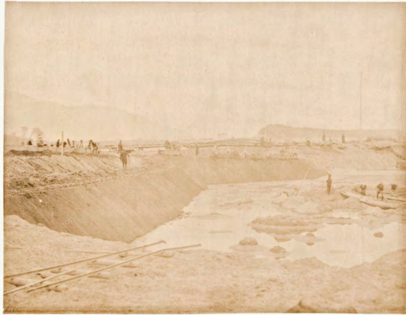
岐阜縣 油津島 掘削機橋 南より 北の望
