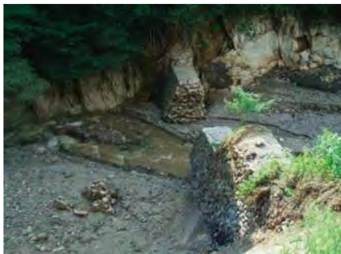
石川県板ヶ谷川2号堰堤
