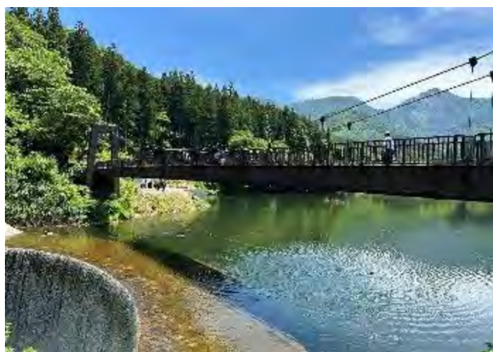
砂防堰堤で創出された親水空間 （大源太川第1号砂防堰堤）
