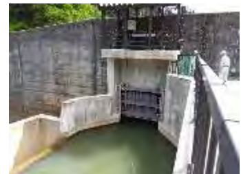
取水口と沈砂池（左岸側袖部）
