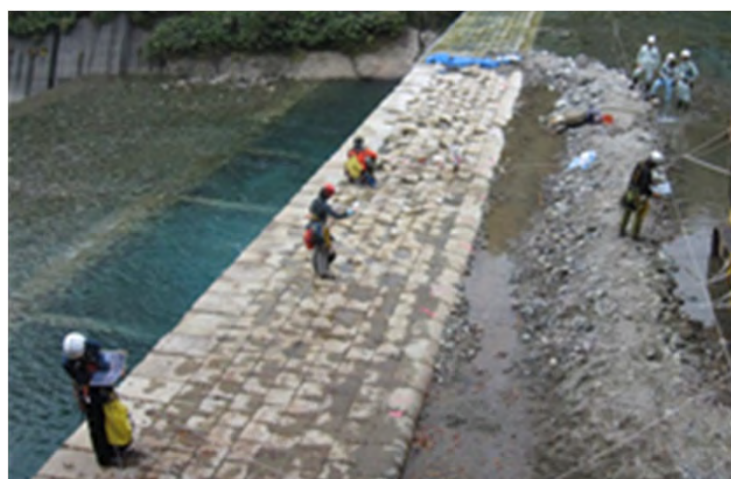
石積砂防堰堤天端の詳細外観調査
