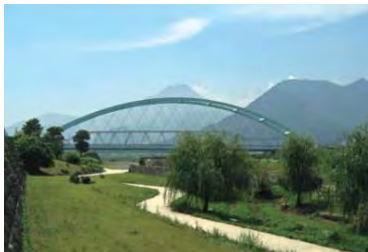
水無川導流堤下流 「われん川整備」に伴う樹林整備
