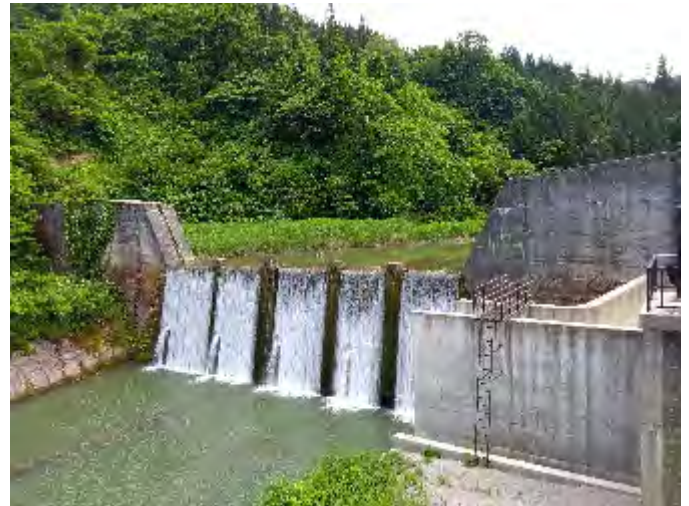
舩玉砂防堰堤（山形県最上郡大蔵村）
