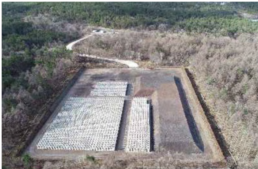
ストックヤードの例（浅間山直轄火山砂防事業）
