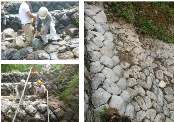
図-3 修理作業状況(左上下)と、修理後の状況(右)
