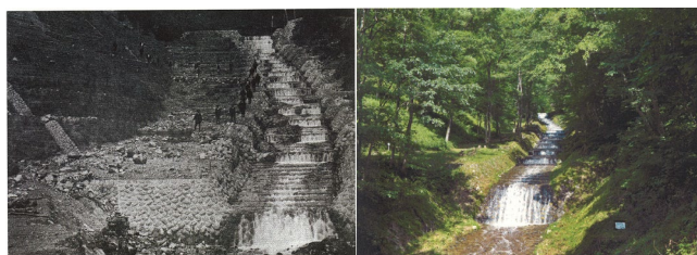
図-1 牛伏川本流水路 竣工時（左）と現況（右）
