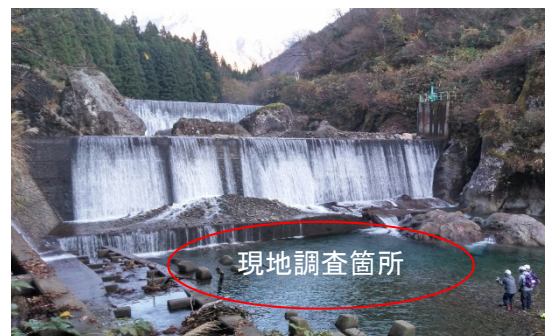
図-2 高石砂防堰堤 正面写真
