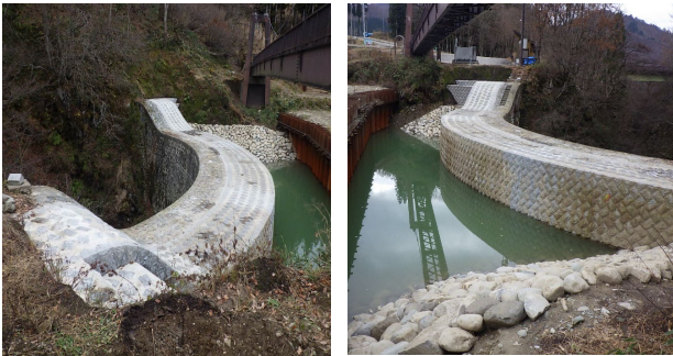
上流腹付けが完了した大源太川第一号砂防堰堤
