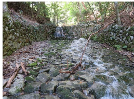
図6 空石積堰堤（堤高3.5m）と石積流路工
