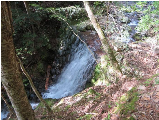
図5 空石積堰堤（堤高5.7m 緩やかなアーチ構造）
