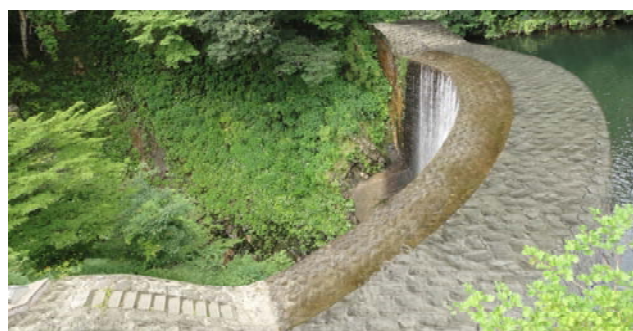
図-3 施設の外観や周辺環境へ配慮した仕上げ
