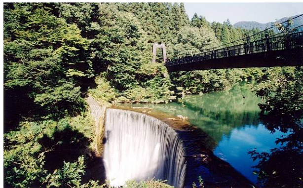
大源太川第一号砂防堰堤（左岸下流から）
