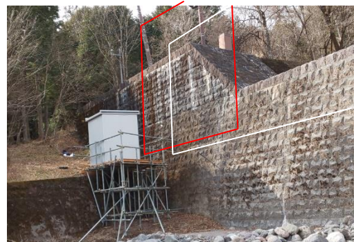
写真-2 観測倉庫と滝尾砂防堰堤
