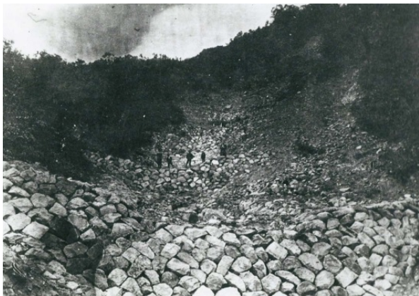
図-2 当時の砂防設備の施工写真の例
