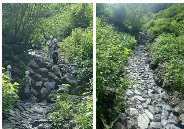
図-6 現存を確認した砂防堰堤と水路石張工の例
