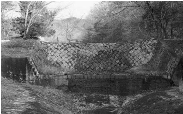
図-1 不動川第5堰堤
