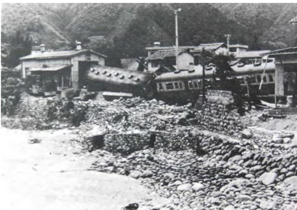
図-26 太田川の濁流に道床を洗われ、加計駅構内で転覆した列車 (加計町)
