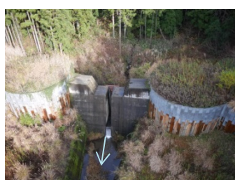
写真-2 鋼矢板の変色
