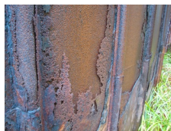
写真-3 剥離状の錆
