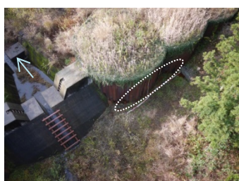
写真-1 腐食の位置
