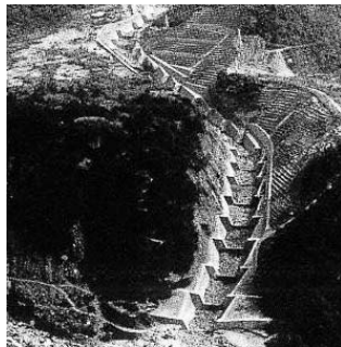
泥谷砂防堰堤群
