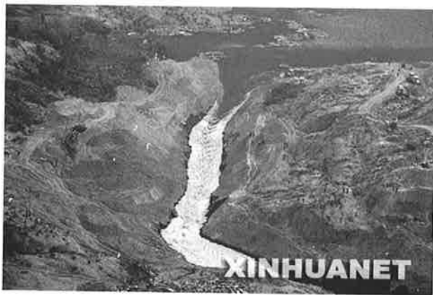
写真-1 唐家山天然ダム。導流溝を越流し始めて3日後(2008年6月9日)の状況(新華社通信)
