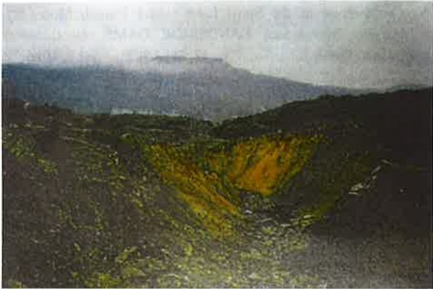
写真-4 排水路の侵食状況 (2001.11 撮影) 17)
