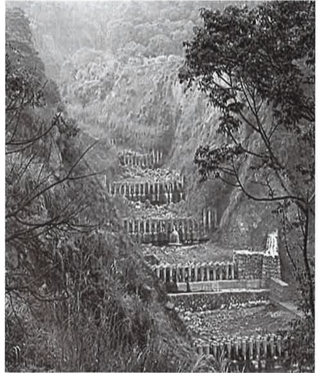
写真-6 その後の状況 (2007.11.29 千木良撮影) 18)
