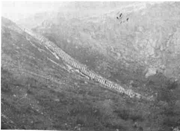
写真-1 大柳川の天然ダムで施工された木製の排水仮樋（箱樋、山梨県砂防課資料）
