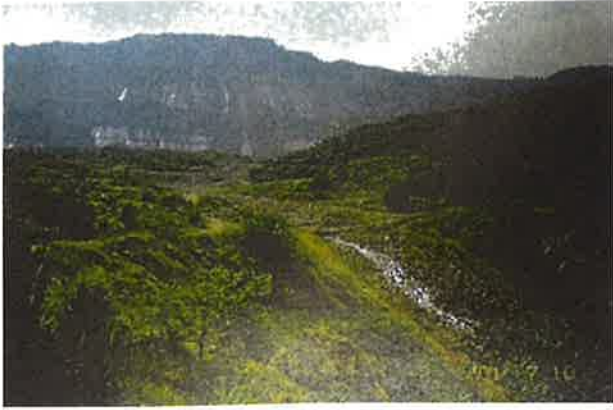
写真-3 被災前の空石積の状況 (2001.7 撮影) 17)
