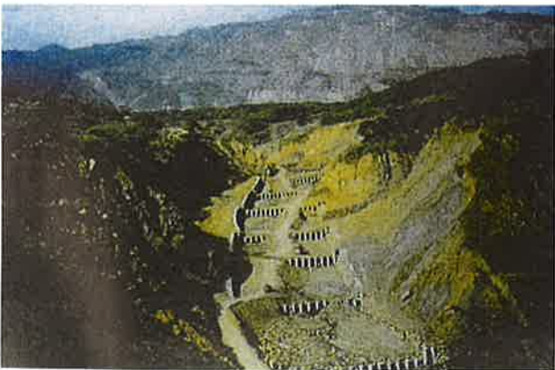
写真-5 鉄筋コンクリート杭による溪床固定 (2002.12 撮影) 17)
