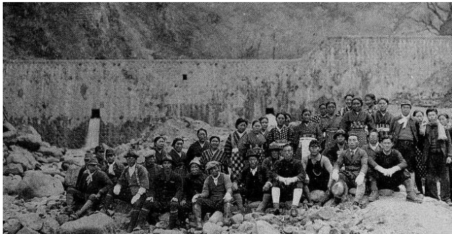
写真-1 濁沢第2砂防堰堤竣工時の写真（土工以外の作業員の多くを女性が占めている）
