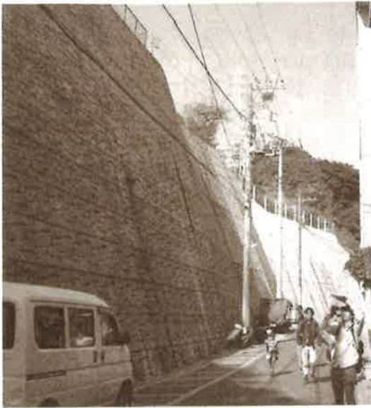
写真1 慰霊塔に続く急斜面に構築された急傾斜地対策 (秋山晋二撮影)
