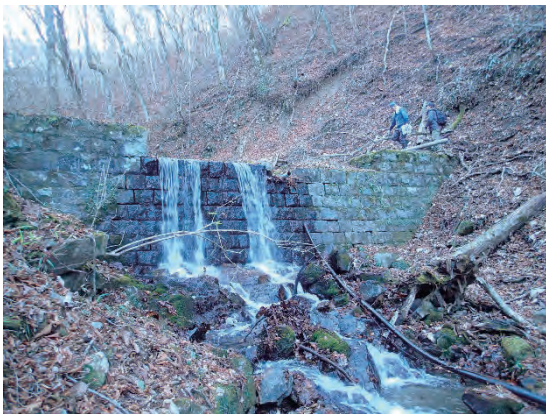
金場澤の量水堰堤（布積）
