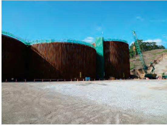
樽前山覚生川 鋼製セル型堰堤
