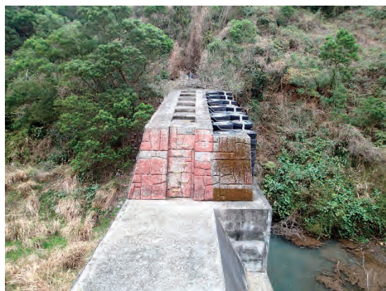
針原川 古タイヤを用いた緩衝工
