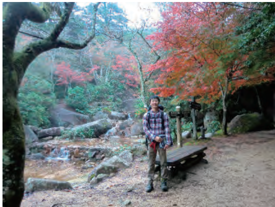
紅葉谷の野面石の護岸と床固め工
