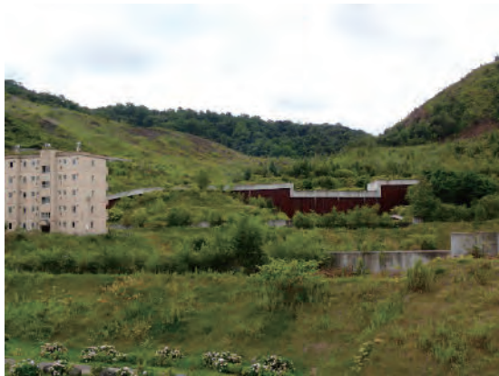
有珠山西山川 二重鋼矢板の鋼製堰堤
