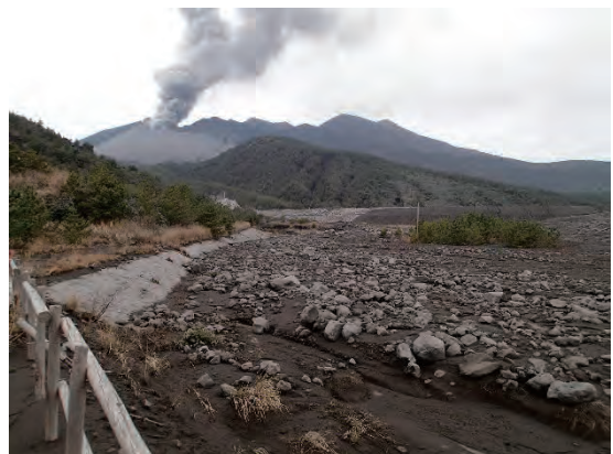
黒神川 遊砂地工
