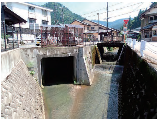
神宮川砂防 函渠の終点
