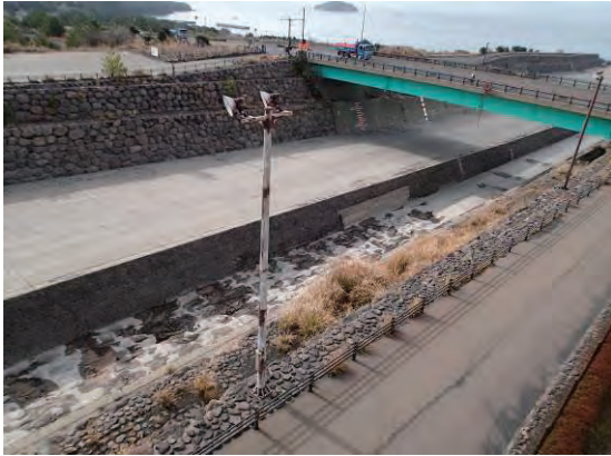
野尻川 流路工
