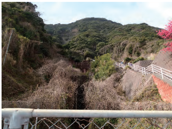
竜ヶ水第2 砂防堰堤
