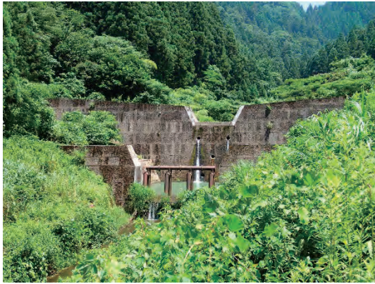
神宮川砂防堰堤
