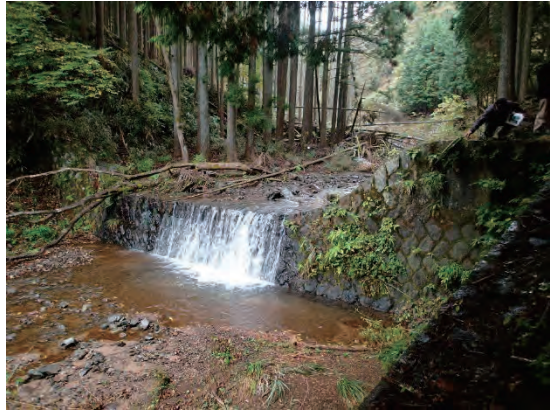
湯船沢下流堰堤 竣功 昭和5年6月13日 内務省東京土木出張所
