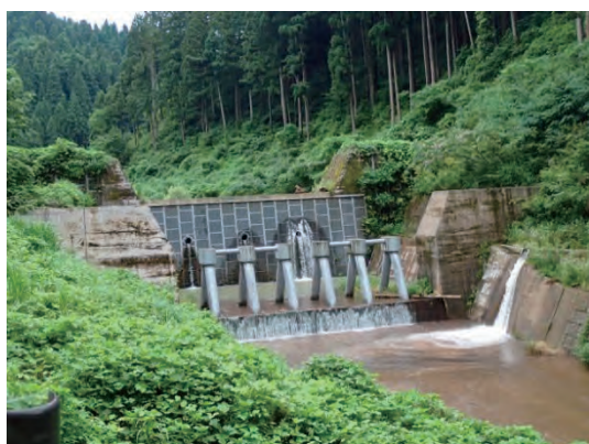
三ツ俣川砂防堰堤
