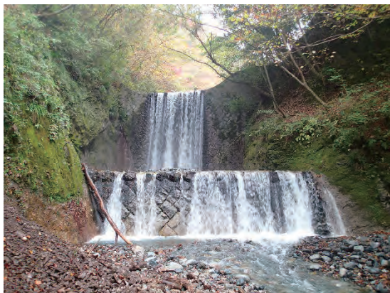
小川谷の内務省堰堤 堤高 10m
