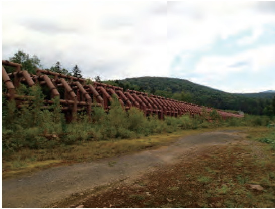
十勝岳 富良野川 鋼製透過型堰堤
