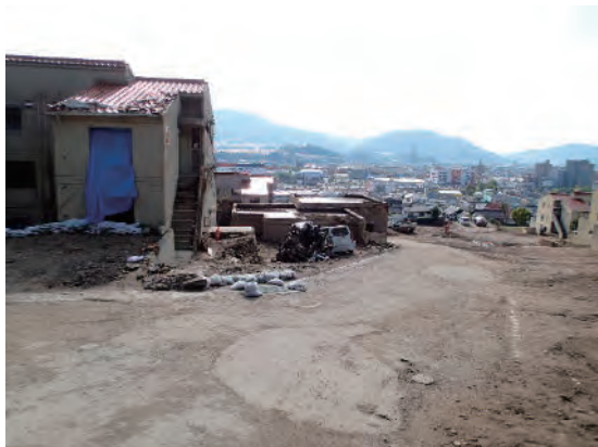
八木 3 丁目県営住宅の被災状況
