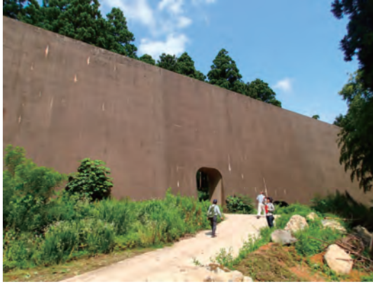
飯降地区雪崩対策 雪崩防護工
