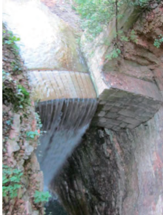
ポンテ・アルト砂防堰堤（イタリア）
