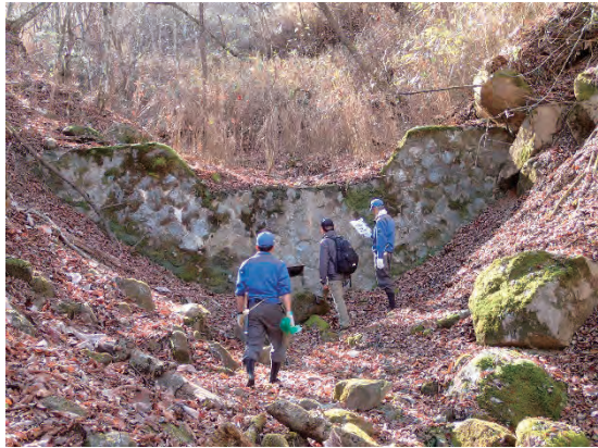
長尾澤の石積堰堤（谷積）
