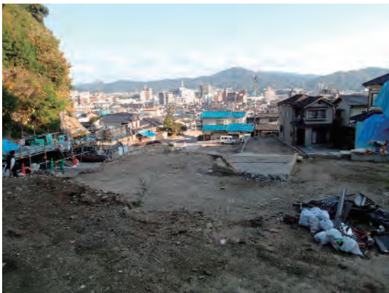
緑井地区の被災状況
