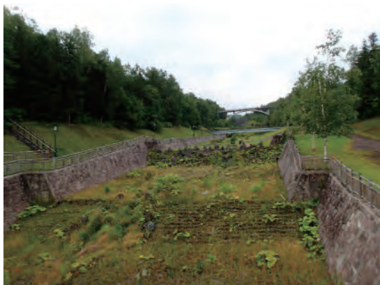
十勝岳 尻無沢流路工
