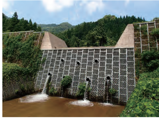
蔵作川砂防堰堤
