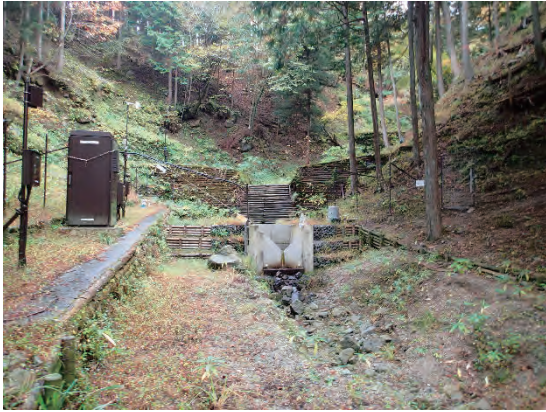
ヌタノ沢 量水堰堤
