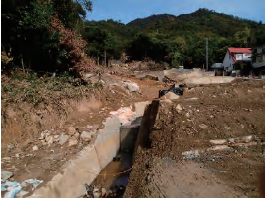
八木3丁目の既存水路
