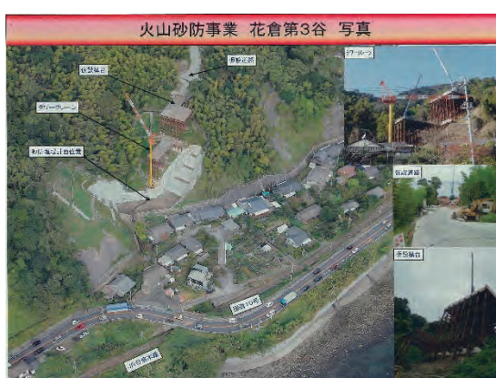
花倉地区 砂防工事の状況 (当日資料より)
