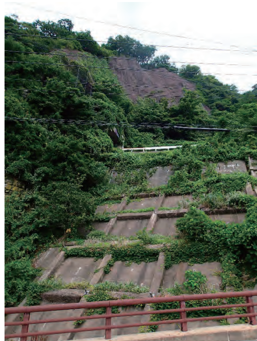
急傾斜地崩壊防止施設
