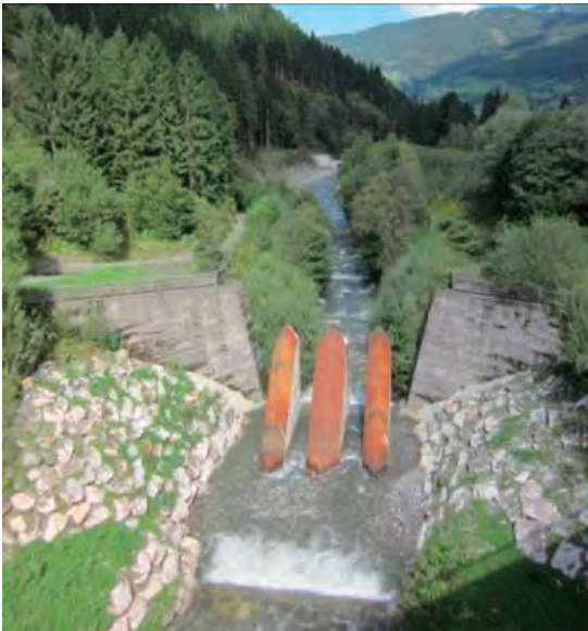
トリーベンバッハの土石流ブレーカー（オーストリア）
