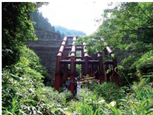
前谷川鋼製堰堤
