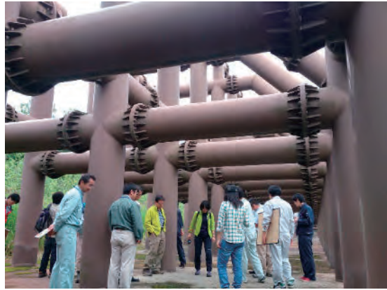
十勝岳 富良野川 鋼製透過型堰堤内部
