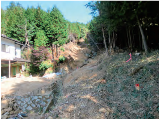
河辺東地区 土石流が発生した沢
