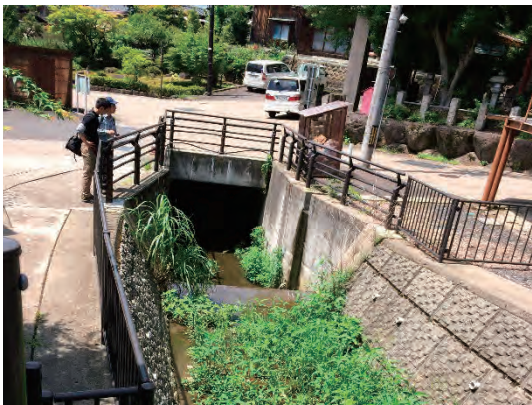
神宮川砂防 函渠の起点
