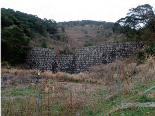
針原川 新設砂防堰堤と崩壊地
