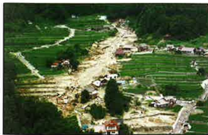
写真-1 図-4 上流部の被災状況 5)
