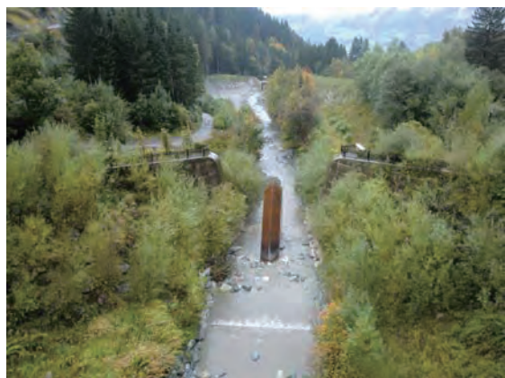
● 砂防堰堤の連続配置状況
