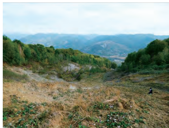
キルレスチ泥流調査の源頭部地すべり状況
