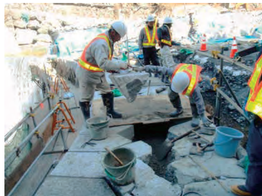
上蔵砂防堰堤の改修施工状況
