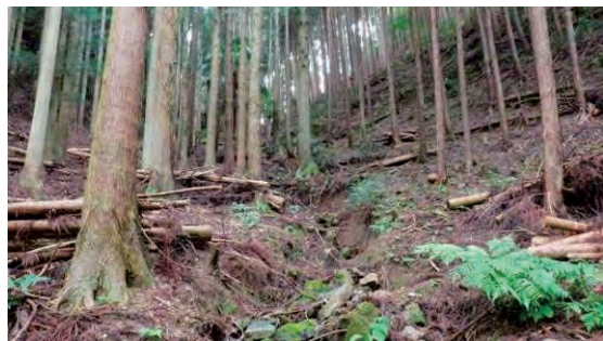
鋼製簡易流木止め施設
