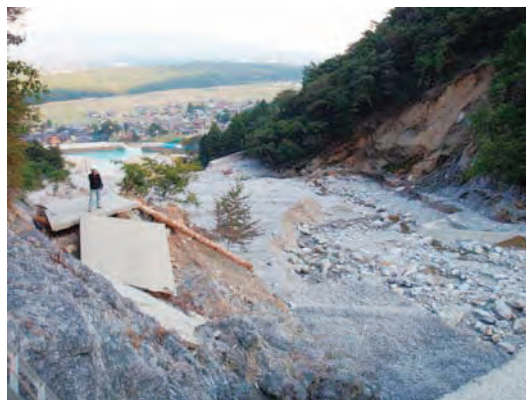
土砂を捕捉した遊砂地
