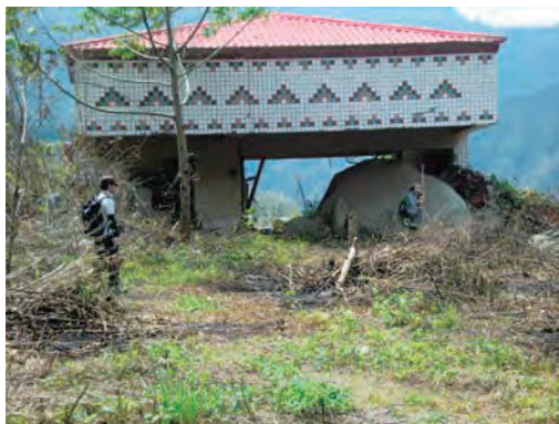
小林村那瑪夏地区土石流被災地
