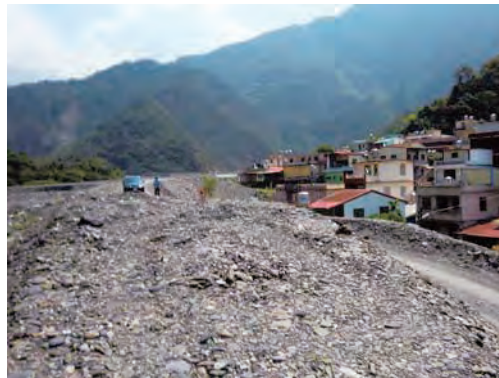
同左被災状況
