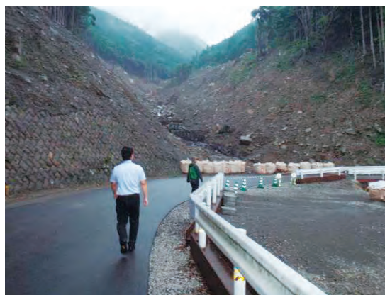
平鍋深層崩壊発生溪流
