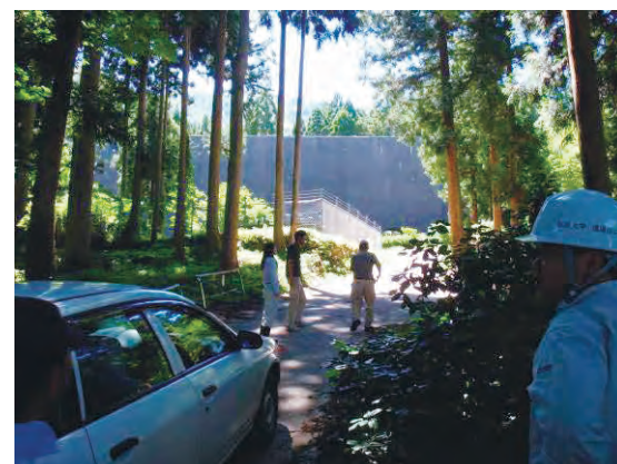
雪崩防護擁壁
