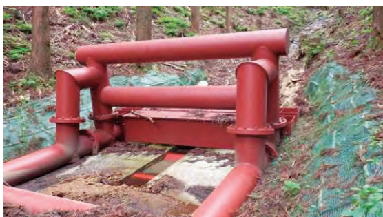
間伐木を利用した土留工
