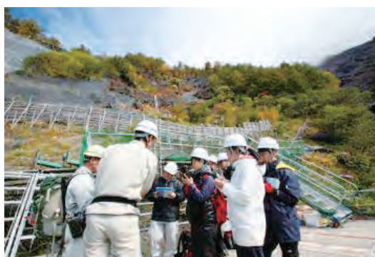
大沢崩れ源頭部工事現場
