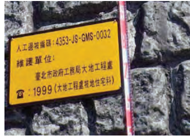
同左擁壁の管理標識
