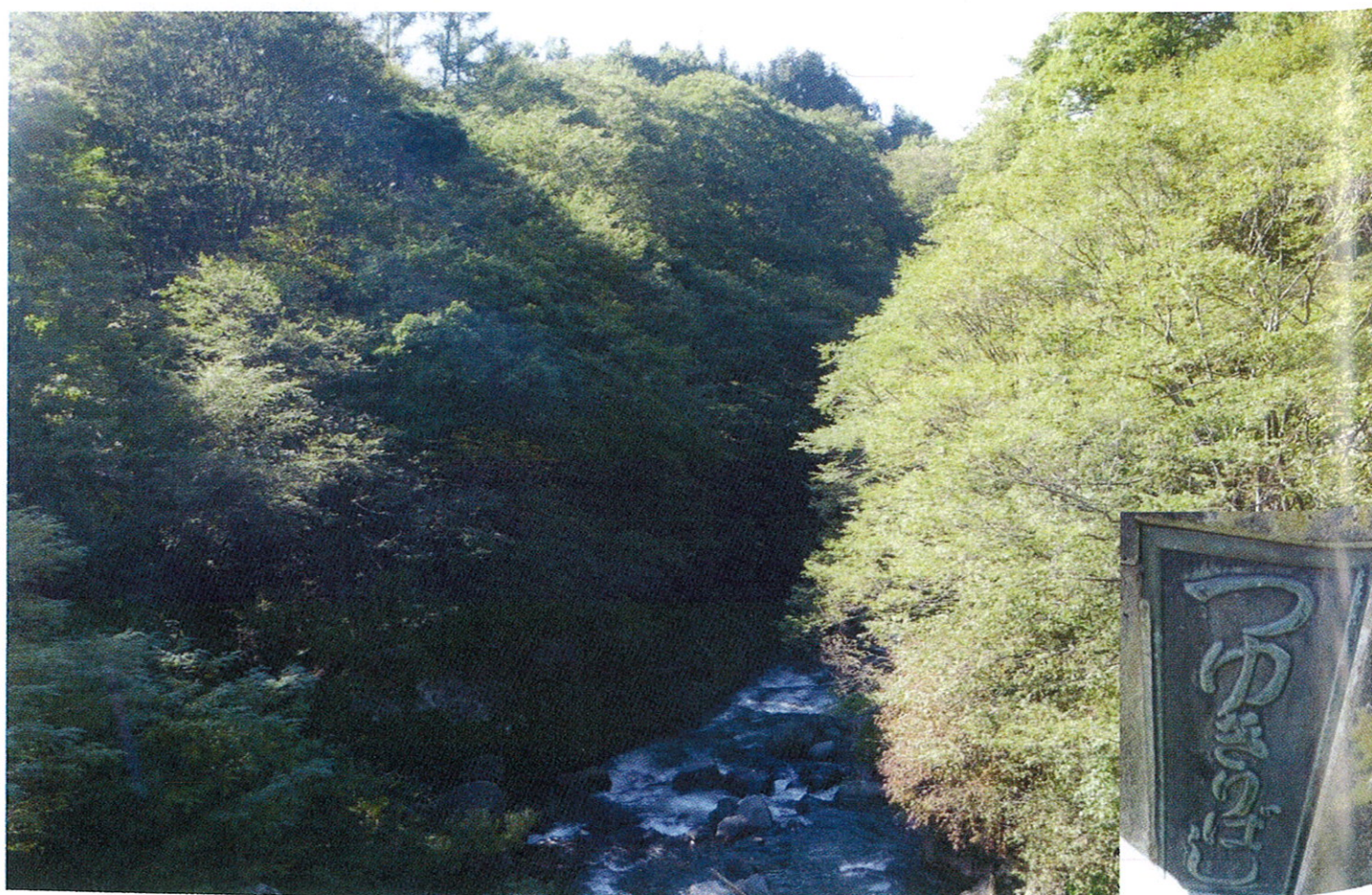
露切橋からみた瀬替地点の湯川狭窄部 露切橋より下流の狭窄部は勾配が急（水平距離 300m で 10m 低下）である。
