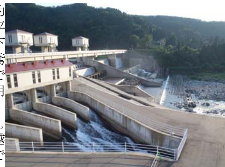
写真1 現在の横江堰堤(H22撮影)
