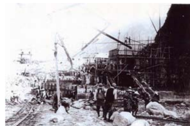
昭和10~12年撮影 写真2 本堤工事状況(左岸)
