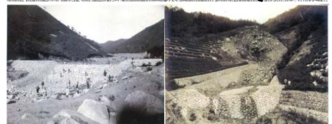
図-4 砂防設備位置図 6) と当時の竣工写真(山梨県所蔵)
