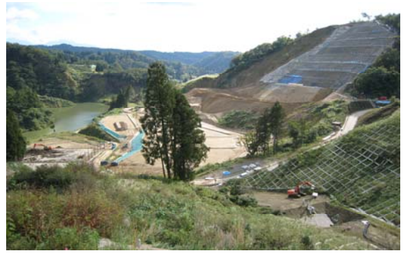
写真—2 南平地区の工事用道路
