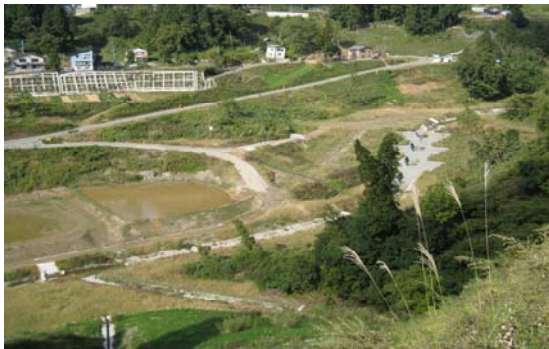
写真—1 油夫地区の押さえ盛土工
