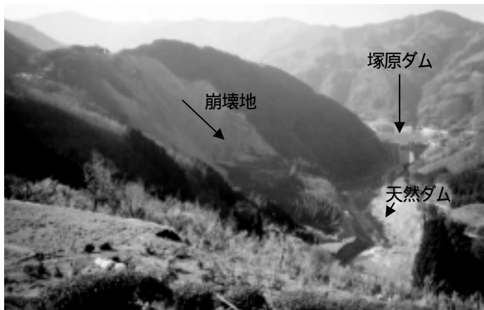
図-2 崩壊地(h18.2撮影)
