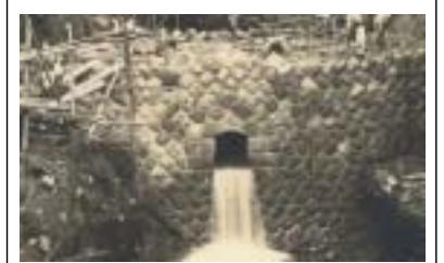
栃木県稲荷川流域釜沢下流砂防堰堤 接合に配慮して間知石を積み上げている
