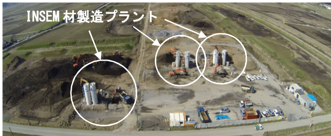
写真-3 九州北部豪雨災害 阿蘇地域集中プラント実施例 (INSEM)
