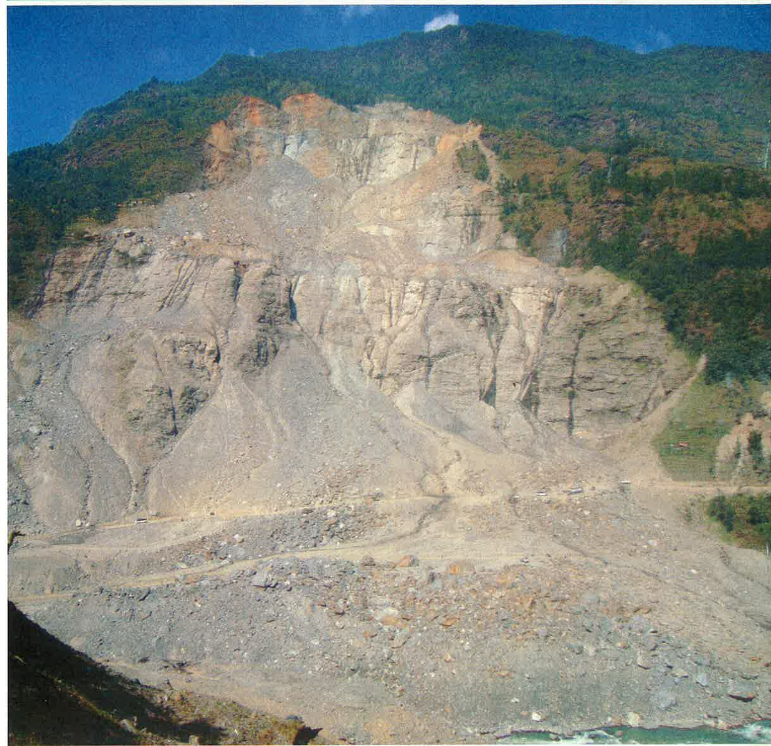
जुरे पट्टिरो माङ्खा गाविस, सिन्धुपाल्चोक । Jure Landslide at Mangkha VDC Sindhupalchok
