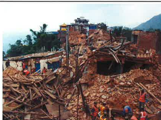
Sindhupalchouk郡の中心地Chautaraの状況(痩せ尾根上に並ぶ人家で被害が著しい一地震動増幅のためか?)
