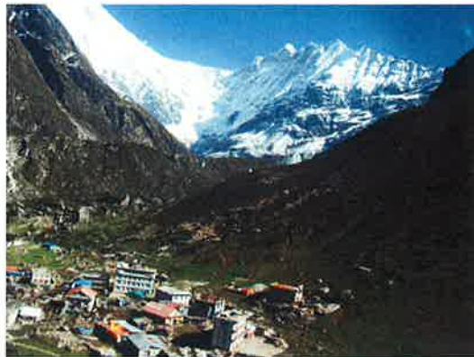
崩落の際の爆風?で建物が損壊したKyanjin集落 (Lantan, Rasuwa)
