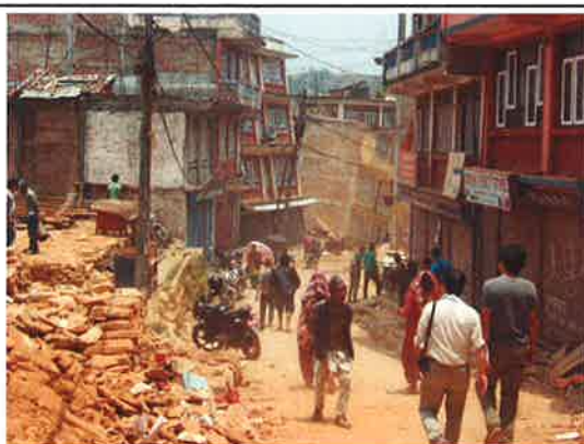
Chautara市街の状況(尾根沿いに発展した市街地では、尾根部の切土を盛った斜面に基礎がある建物で被害が大きいようである。)
