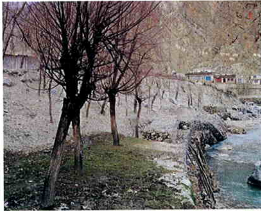
Fig.1 フトン籠による石積み護岸 (カリガンダキ川)
