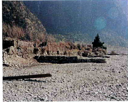
Fig.2 フトン籠による水制工 (タパ川)
