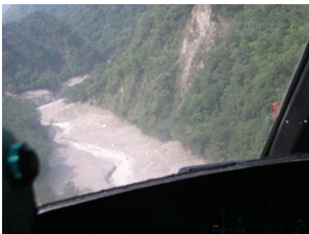
写真 6.4.3 第 2 屈曲部左岸での河岸侵食
