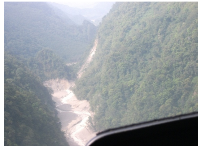
写真 6.4.2 第 1 屈曲部左岸での河岸侵食
