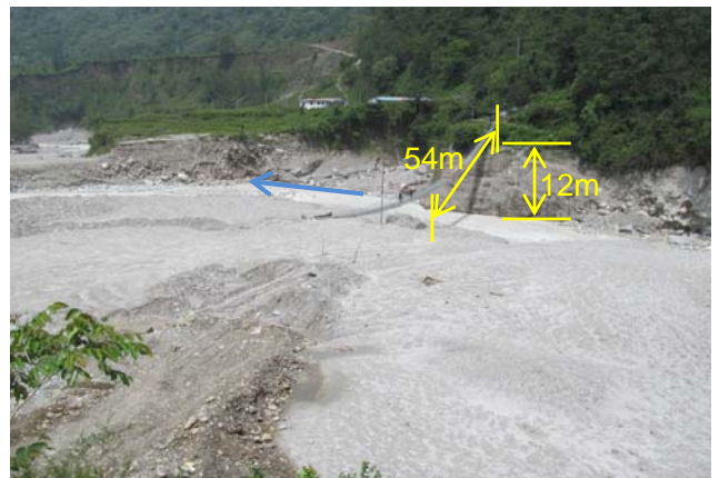
Kharpani 吊り橋付近での被害発生(写真中央の吊り橋が閉塞し、洪水が左岸の段丘面に乗り上げた)
