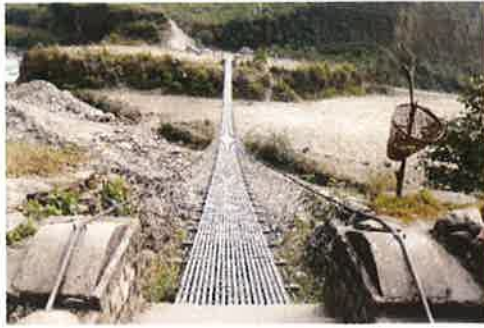
復旧した吊り橋
