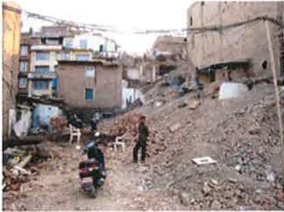
パダンで倒壊した建物
