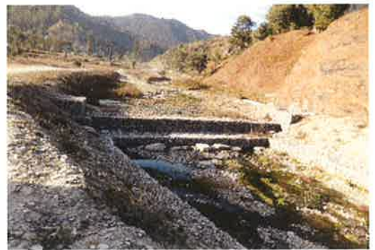
パルンの河川改修
