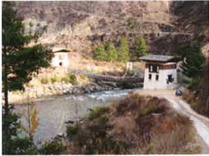
ブータン最古の吊り橋
