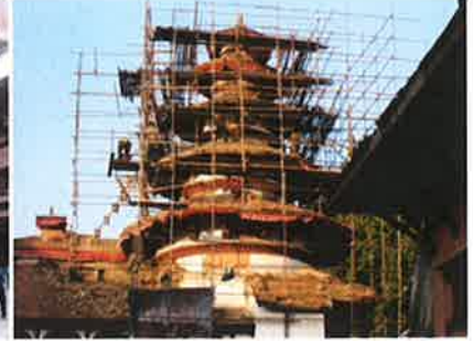
修復が始まった建造物
