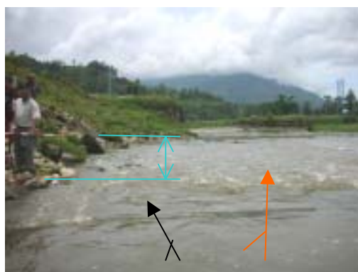
左岸侵食を止める竹柵水制工
