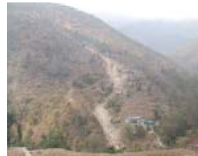
ネパネ地区土石流被災地全景
