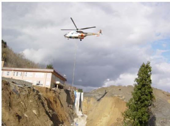
写真 4.7 ヘリによるブロック据え付け
