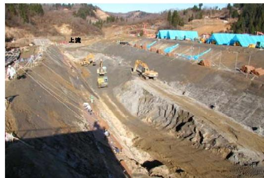
写真 4.3 H16.12.14 東竹沢仮排水路 開削とのり面工
