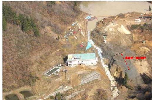
写真 4.10 H16.11.17 東竹沢 呑み口が侵食され、約 25m 後退。上流水位も上昇中
